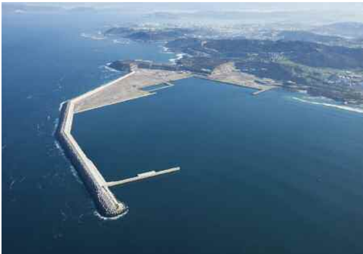
Inversiones en obras portuarias
