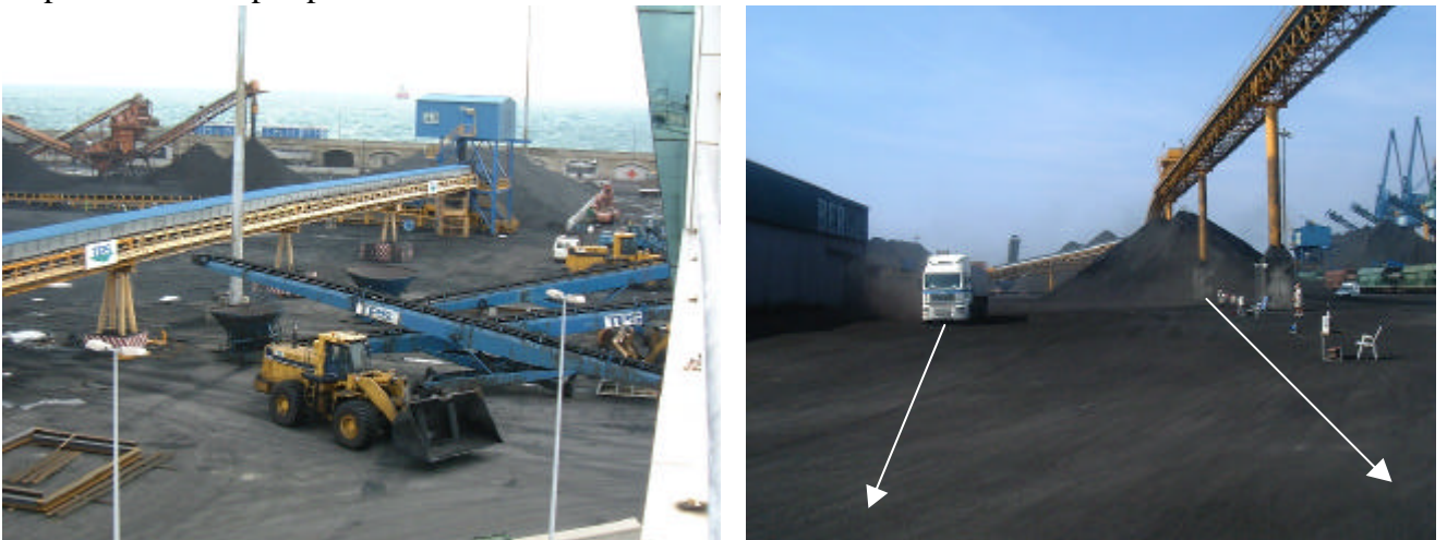
Fotos 5 y 6. Sistemas de transporte mecánico del carbón de hulla y paso de camiones cargados junto a las parvas. En la foto de la derecha se observa el paso de camiones y la disposición de los equipos alineados bajo la cinta transportadora y en paralelo a la dirección del paso de camiones.
