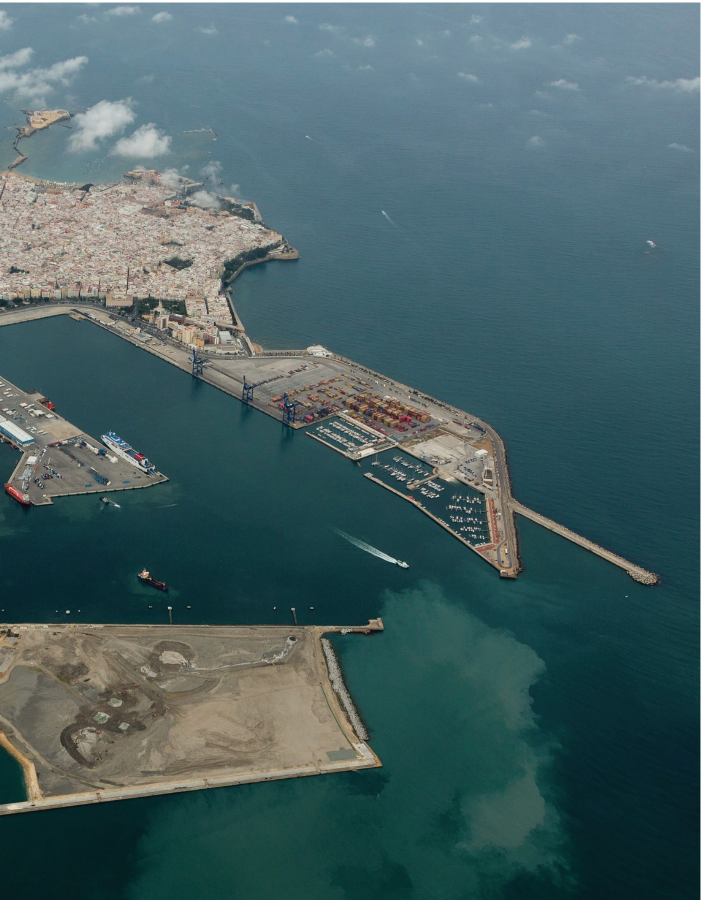
ESTADO DE LA NUEVA TERMINAL DE CONTENEDORES EN JUNIO DE 2014
