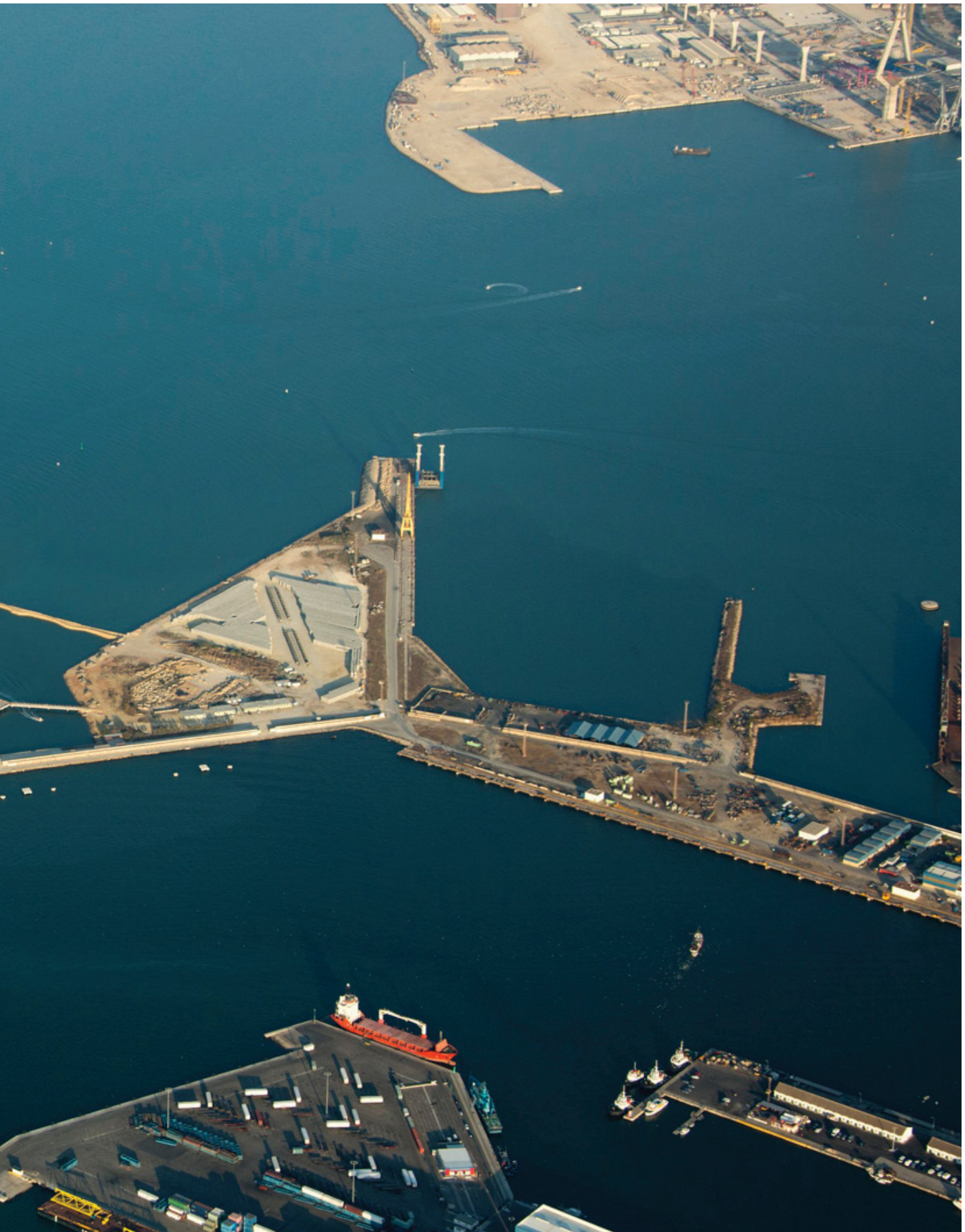
NUEVA TERMINAL DE CONTENEDORES EN CONSTRUCCIÓN
