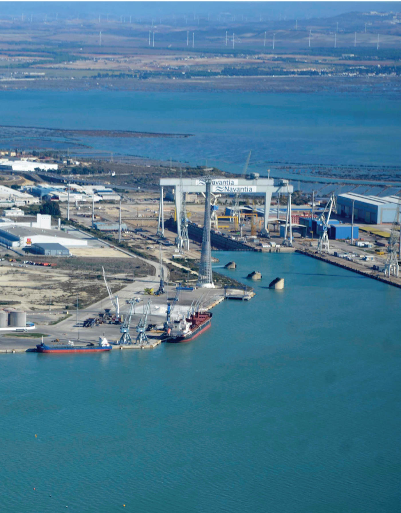
NUEVO PUENTE EN CONSTRUCCIÓN Y MUELLES DE LA CABEZUELA-PUERTO REAL
