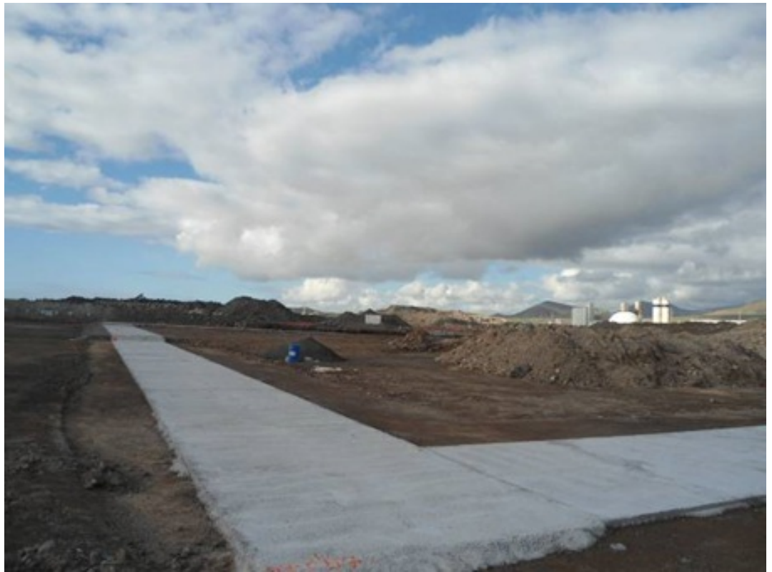
Ilustración 7. Vista del hormigón de limpieza
