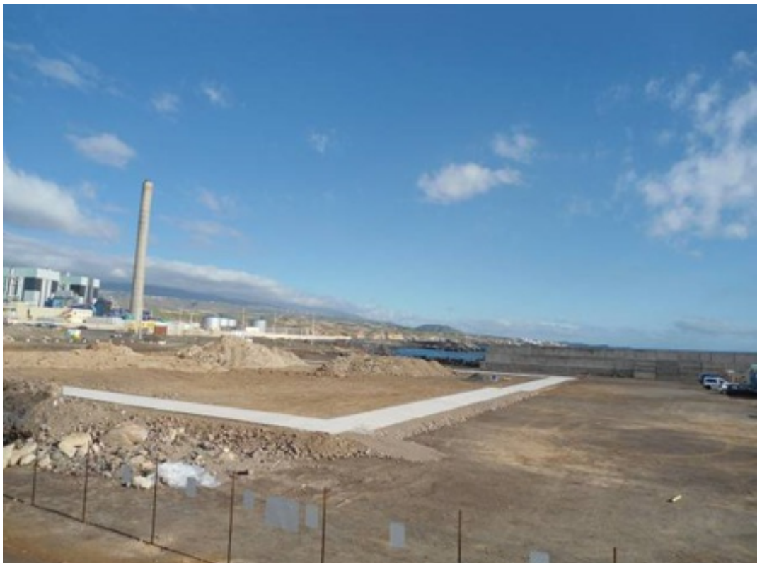
Ilustración 6. Vista del vallado y del hormigón de limpieza
