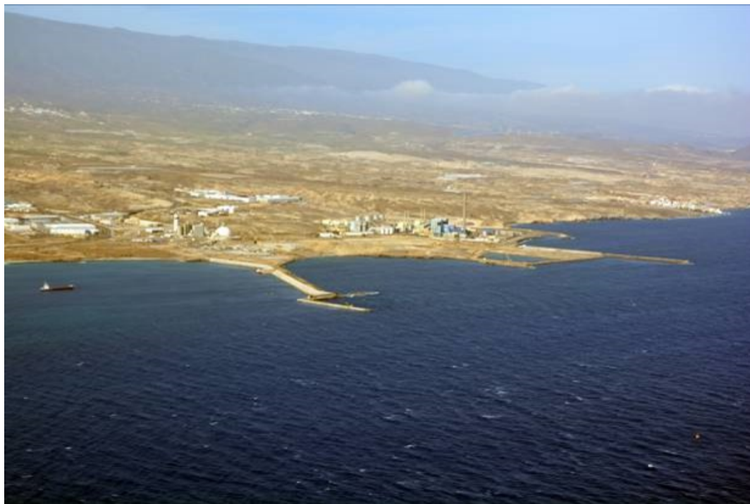
Ilustración 1. Imagen aérea de las obras de Granadilla. Noviembre 2013
