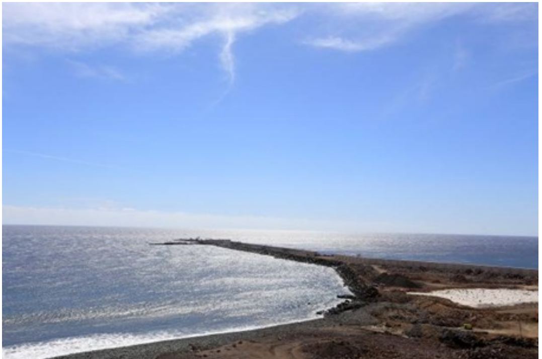
Ilustración 4. Vista general de las obras de contradique del puerto de Granadilla
