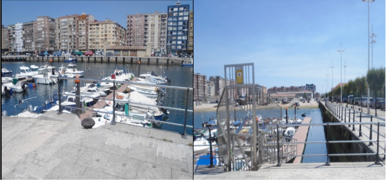
Instalación de 123 metros de barandilla en la Dársena de Maliaño
