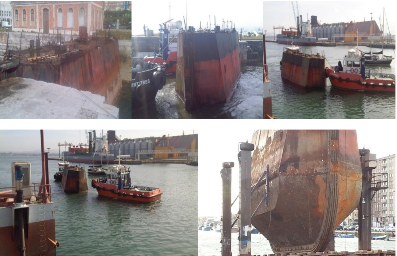
Traslado para su rehabilitación del "Buque Puerta" del Dique Gamazo
