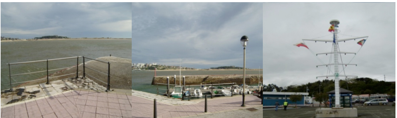
Acondicionamiento en el Puerto deportivo de Pedreña
