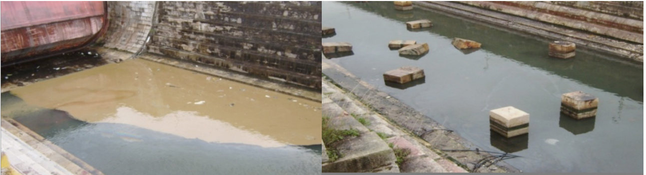
Limpieza de hidrocarburos en Dique Gamazo, tras el desguace de la Draga Loreto
