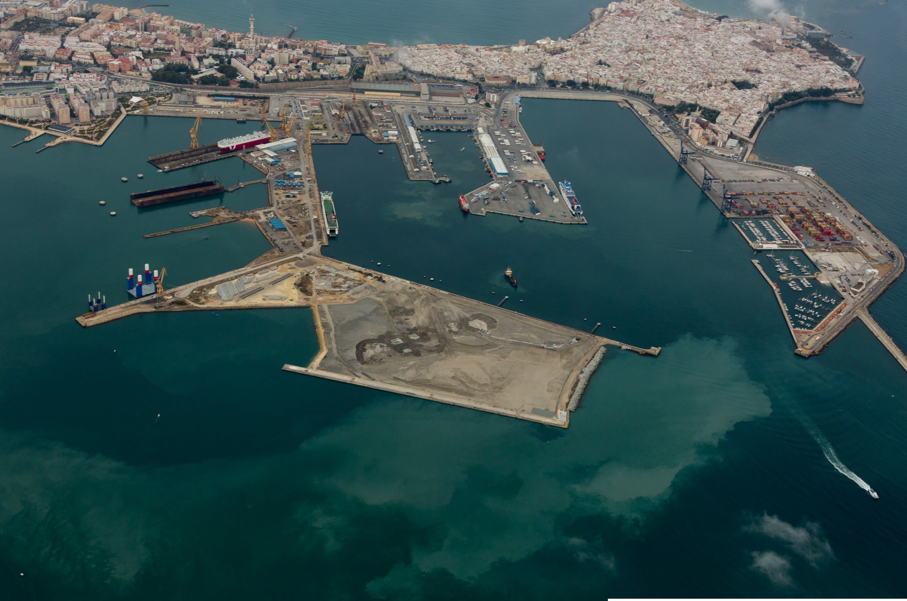
Obras de la nueva terminal de contenedores. Junio 2014. Works at new container terminal. June 2014.
