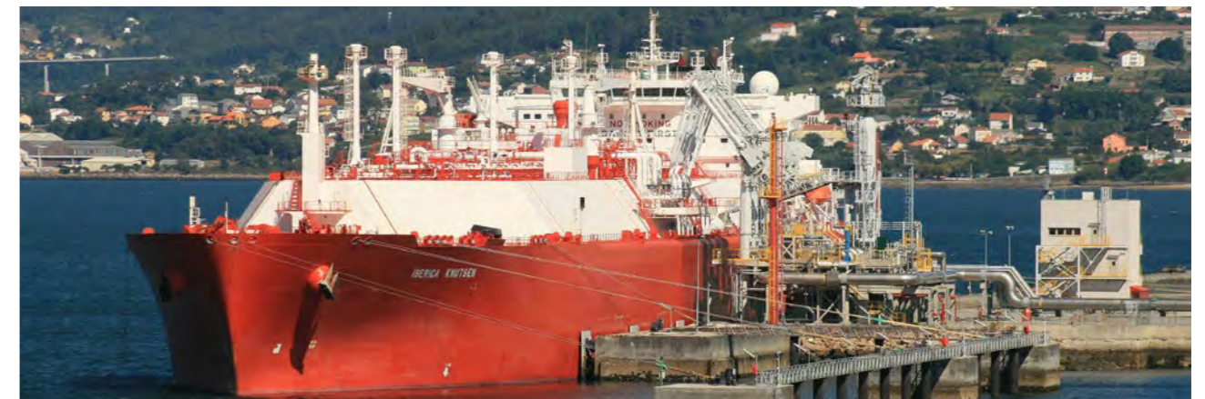
Terminal de gas natural.
