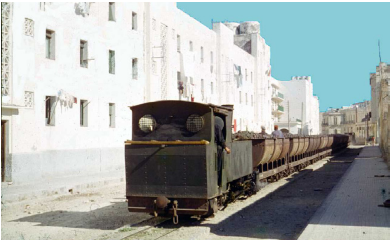
Tren por la calle Álvaro de Bazán
