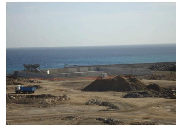
de los futuros rellenos del Muelle de Ribera. Es un dique en talud que tiene tres alineaciones, la primera de 228,87 metros, la segunda y principal de 442,75 metros y una tercera de 42,64 alcanzando un total de 714,26 metros. La explanada terminada está coronada a la cota +4,5 y el espaldón está coronado a la cota +9,00 m.
