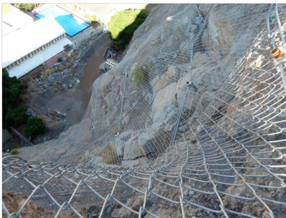
protección tipo pasivo se colocó una barrera dinámica de 1500kJ de capacidad en la parte trasera de la zona de almacenes.
