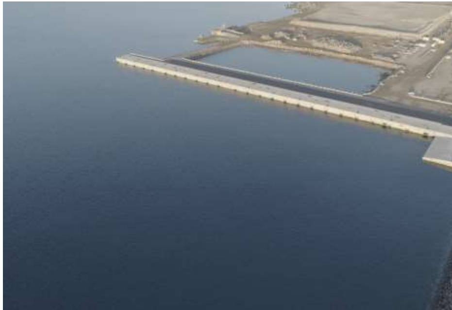
Imagen aérea de las obras finalizadas
