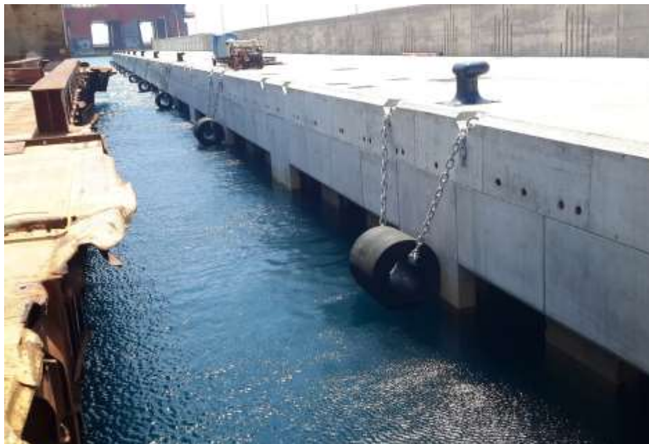
Imagen de las obras de habilitación del contradique finalizadas
