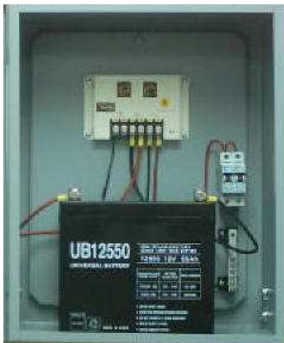
Montaje típico de regulador batería y protección en una baliza de mediano alcance
