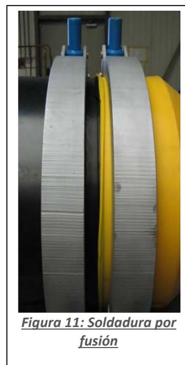
**Figura 11: Soldadura por fusión**
