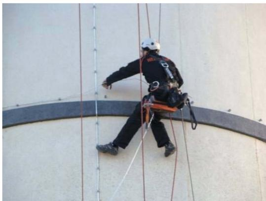
***Figura 13 Instalación del anillo horizontal***
