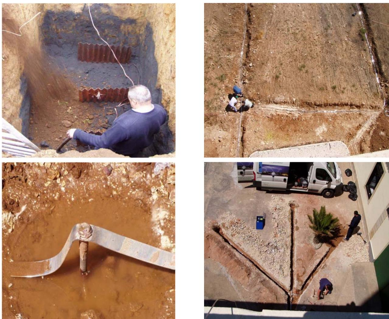
***Figura 19 Diferentes tipos de electrodos de tierra***
