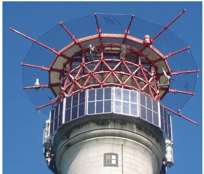
*Figura 6 Pequeño sistema de energía híbrido de un faro*
