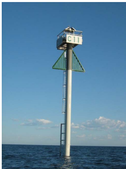
Figura 37 Ejemplos de una estructura fija como marca diurna con aletas unidireccionales
