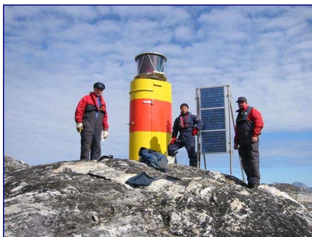
Figura 34 Colores alternativos para la marca diurna de un faro
