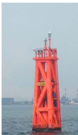
Figura 31 Estructura soporte utilizada como marca diurna
