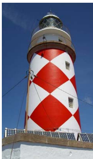
Figura 33 Diseño de rombos para la marca diurna de un faro
