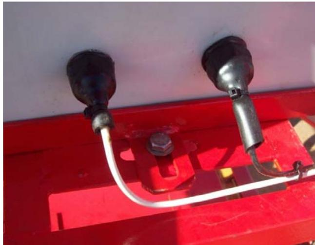
Figura 18 Sellado de entradas de antena y fuente de energía.
