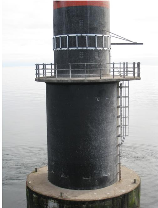
*Figura 2 El Faro de Almgrund (Suecia) provisto de tubos LED*
