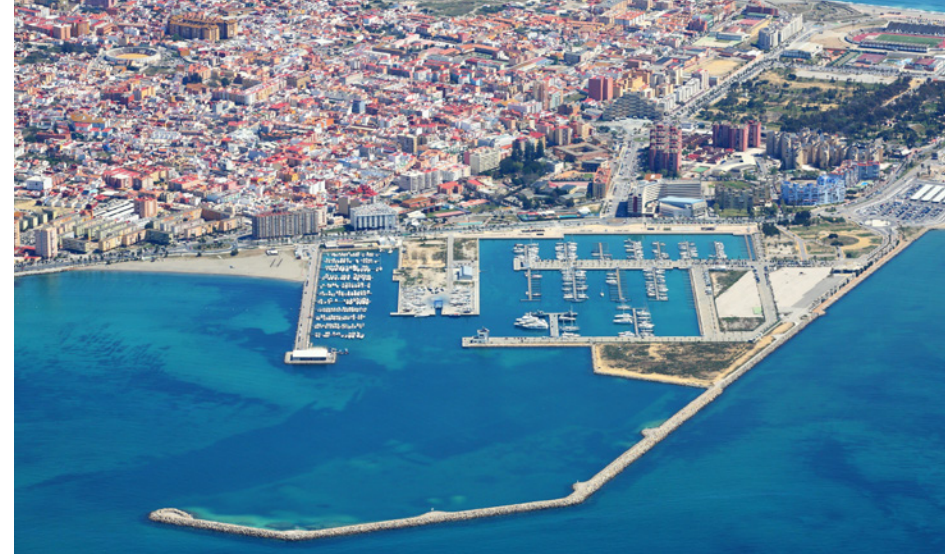
Instalaciones de la actual dársena de La Línea. / La Línea wharf current facilities.
