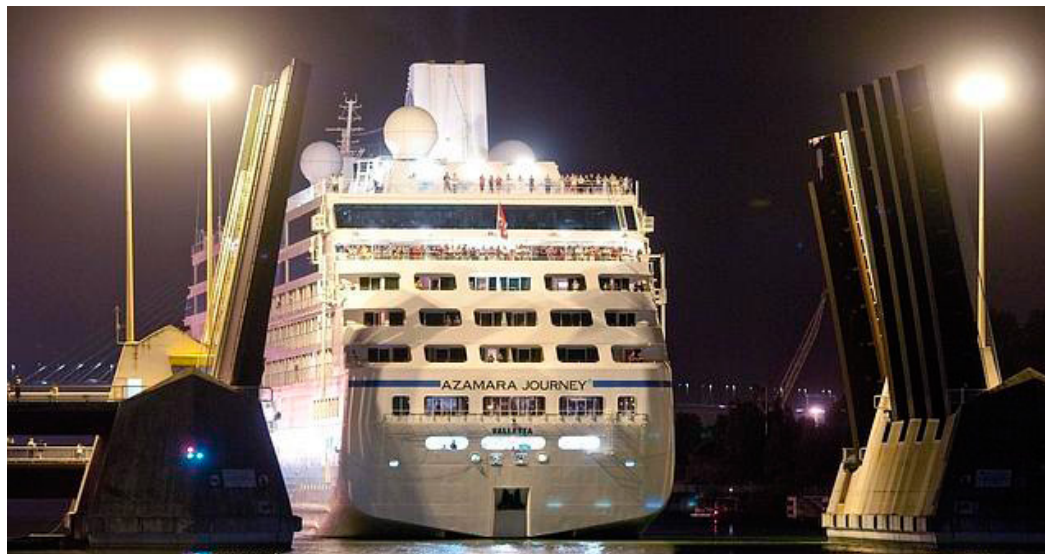
Apertura mecánica del puente de las Delicias en pleno centro de Sevilla. / Automatic opening of the Delicias bridge right in the centre of Seville.
