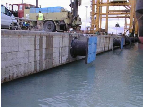
Fotografía 16. Extracción desde la cara superior de la viga cantil de un sondeo vertical hasta alcanzar el hormigón sumergido en un cajón del Puerto de Valencia
