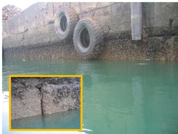
Fotografía 15. Muelle de cajones en ambiente XS3, con buen aspecto general del hormigón, sin síntomas visibles de corrosión, sin fisuración y sin coqueas, tras 31 años de servicio. Cemento puzolánico
