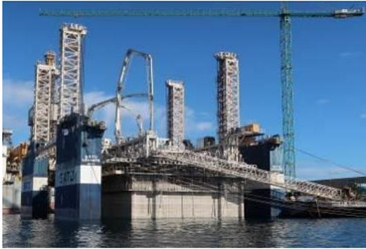
Fotografía 1. Proceso de construcción de un cajón, ya parcialmente sumergido
