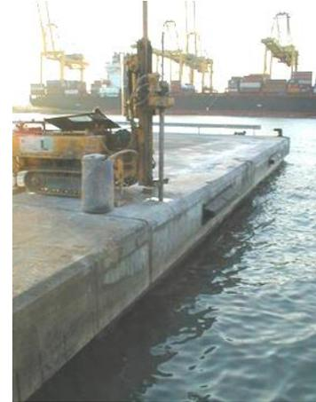
Fotografía 17. Extracción desde la cara superior de la viga cantil de un sondeo vertical hasta alcanzar el hormigón sumergido en un cajón del Puerto de Barcelona
