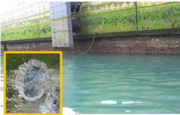
Fotografía 13. Muelle de cajones flotantes en ambiente XS3, con buen aspecto general, tras 2 años de servicio. Detalle de armadura descubierta en el cajón, sin indicios de corrosión. Cemento IIIB/32,5-SR
