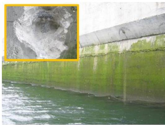
Fotografía 14. Muelle con buen aspecto general en ambiente XS3, tras 2 años de servicio. Detalle de armaduras descubiertas en el cajón, sin indicios de corrosión. Cemento IV/A 32,5 SR/MR
