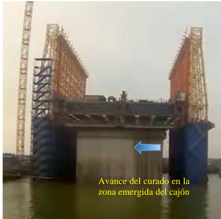
Fotografía 8. Muestra del avance del curado que se ejecuta recorriendo el perímetro del cajón mientras se encuentra en la plataforma de construcción [17]
