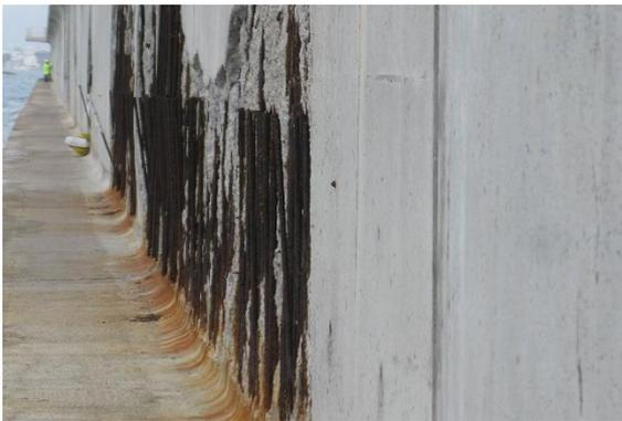
Fotografía 13. Pérdida de recubrimiento por corrosión en la zona de solapes verticales del espaldón de dos diques. Espaldón A
