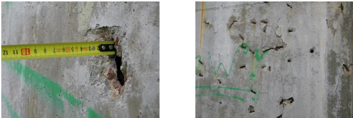
Fotografía 4. Corrosión avanzada por falta de recubrimiento en las patillas y alambres de atado
