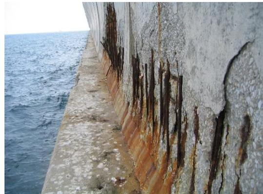
Fotografía 14. Pérdida de recubrimiento por corrosión en la zona de solapes verticales del espaldón de dos diques. Espaldón C
