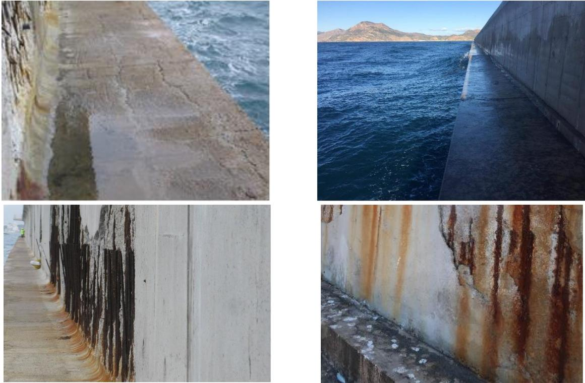
Fotografía 5. Corrosión avanzada por falta de recubrimiento en las patillas y alambres de atado
