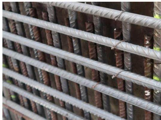
Fotografía 10. Esperas con cloruros en su superficie conformando el armado del espaldón
