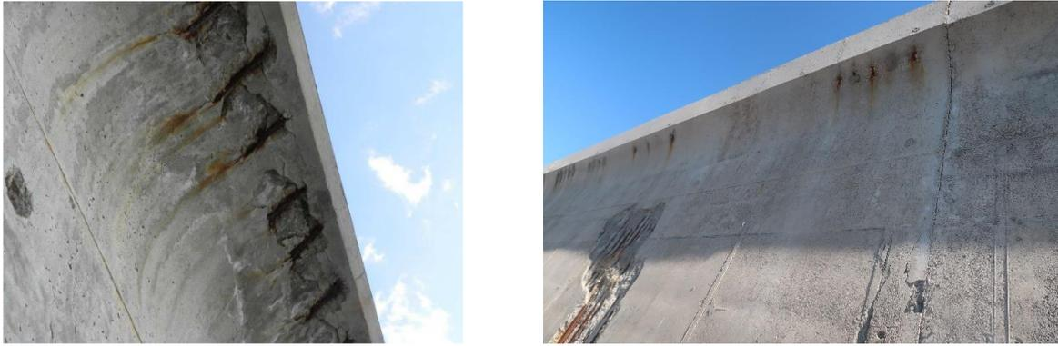
Fotografía 8. Corrosión por falta de recubrimiento en el botaolas
