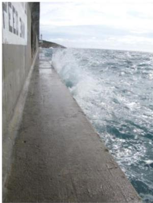
Fotografía 1. Salpicaduras en el paramento exterior del espaldón de un dique
