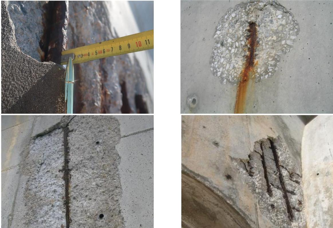
Fotografía 3. Corrosión avanzada en el armado por falta de recubrimiento
