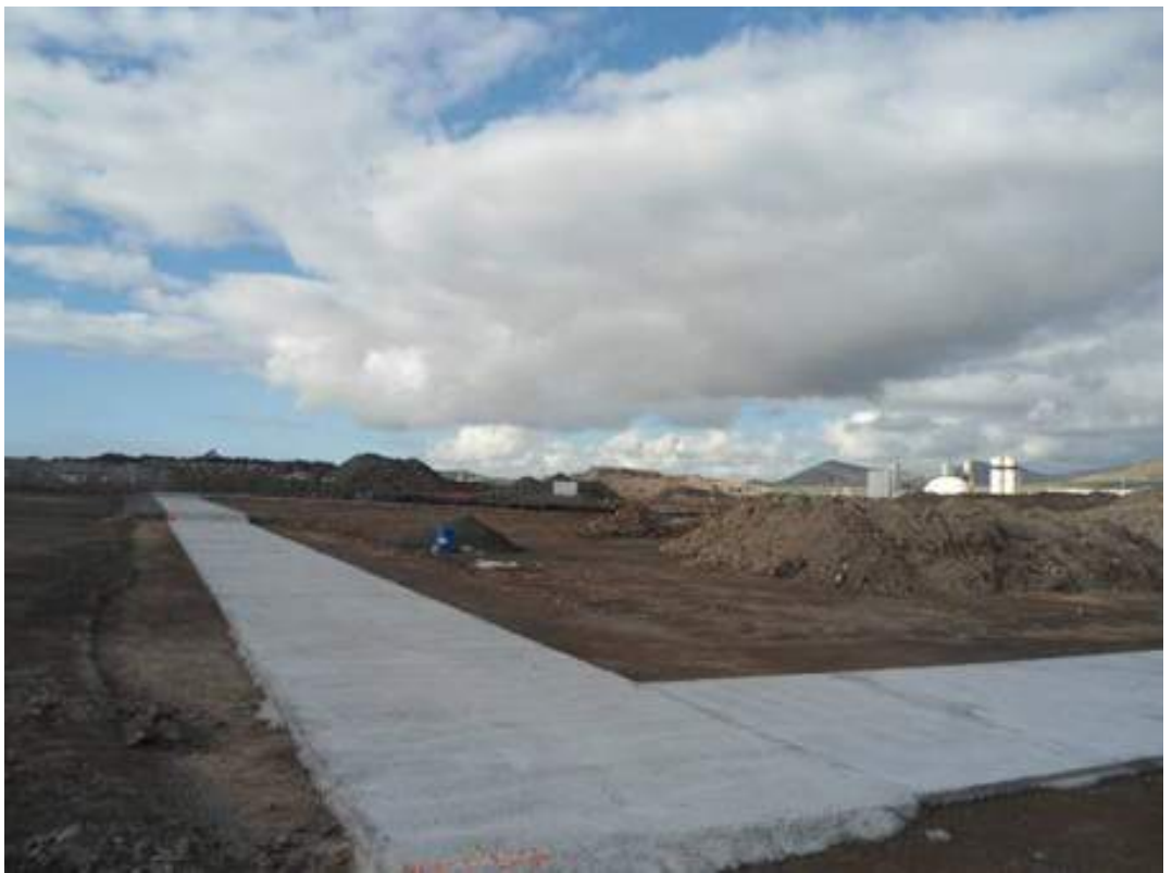
Ilustración 7. Vista del hormigón de limpieza
