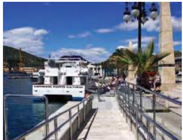
Rampa de mejora de acceso al Catamarán Turístico. Ramp to improve access to the Tourist boat.
