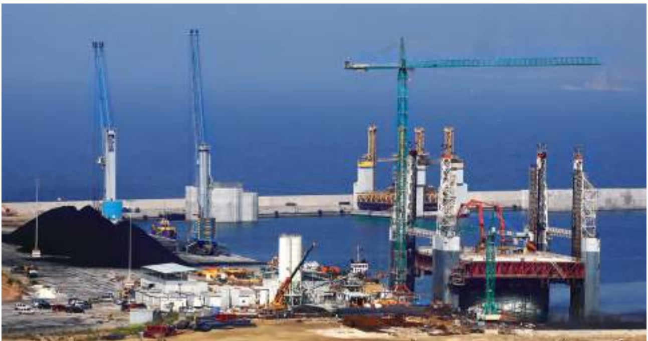
Buques cajoneros en las obras de ampliación de la dársena de Escombreras. Cargo vessels in the extension works of the Escombreras basin.
