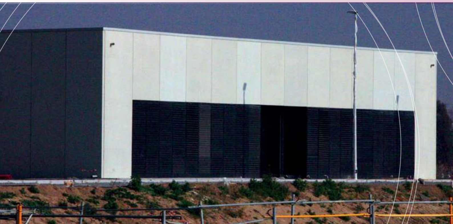
Edificio de maquinaria
