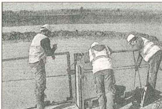
Trabajos de control del agua.
