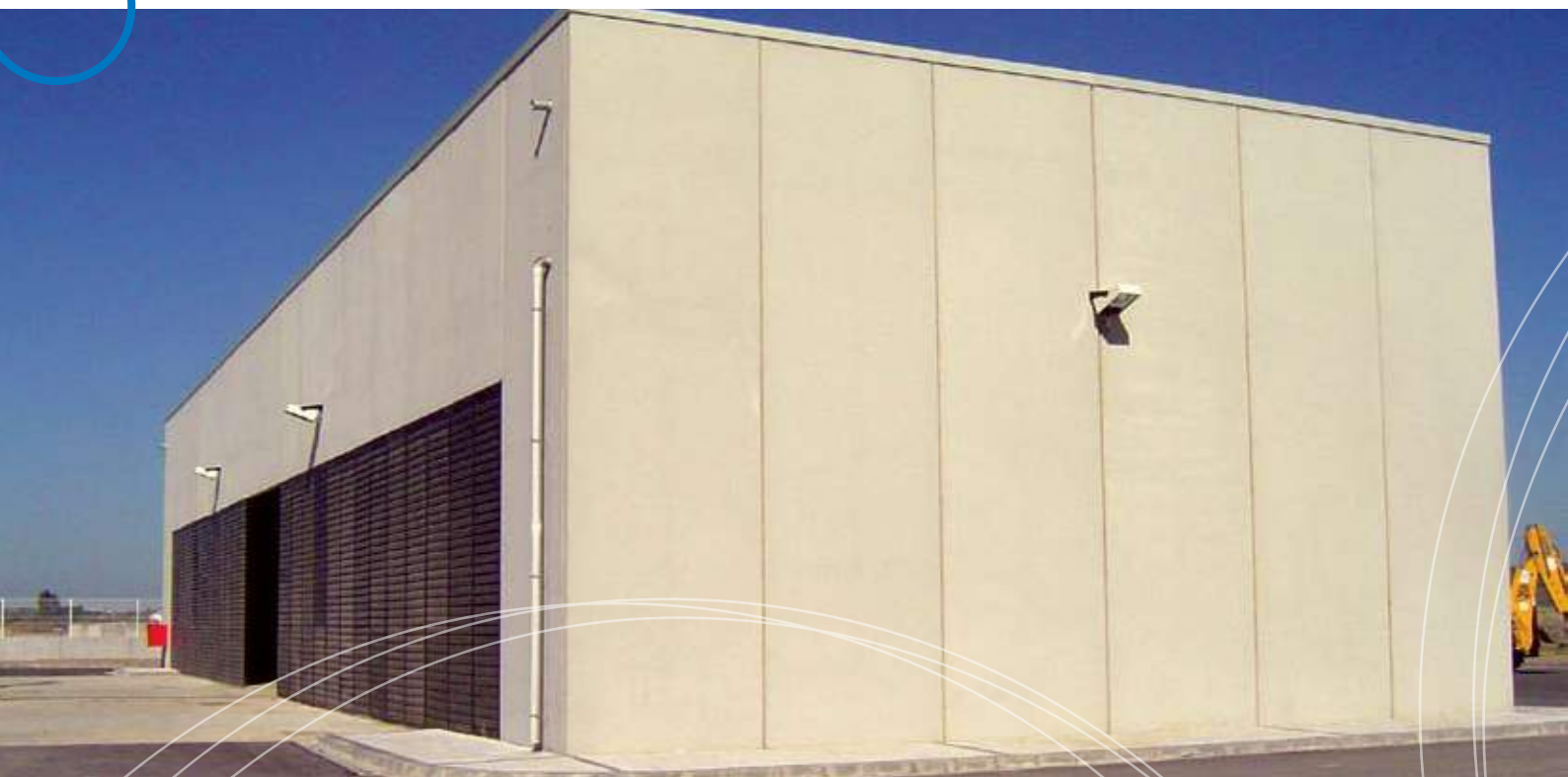
Edificio de taller
