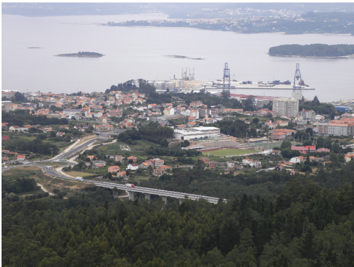
Enlace con autopista
