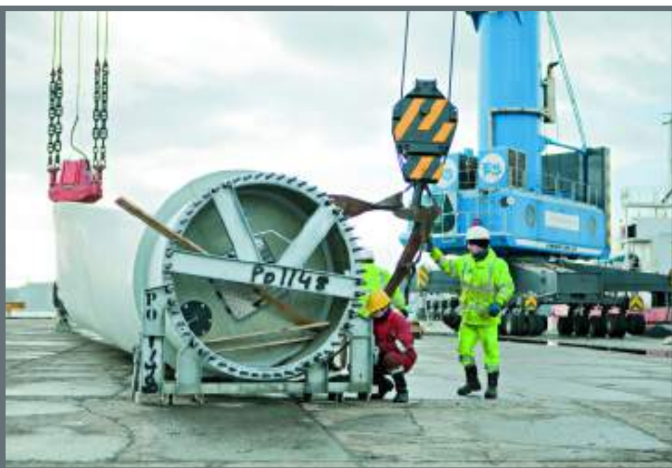
► Movimientos de piezas eólicas
