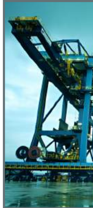
► Pórticos descargadores de la nueva terminal de Endesa en el puerto exterior
