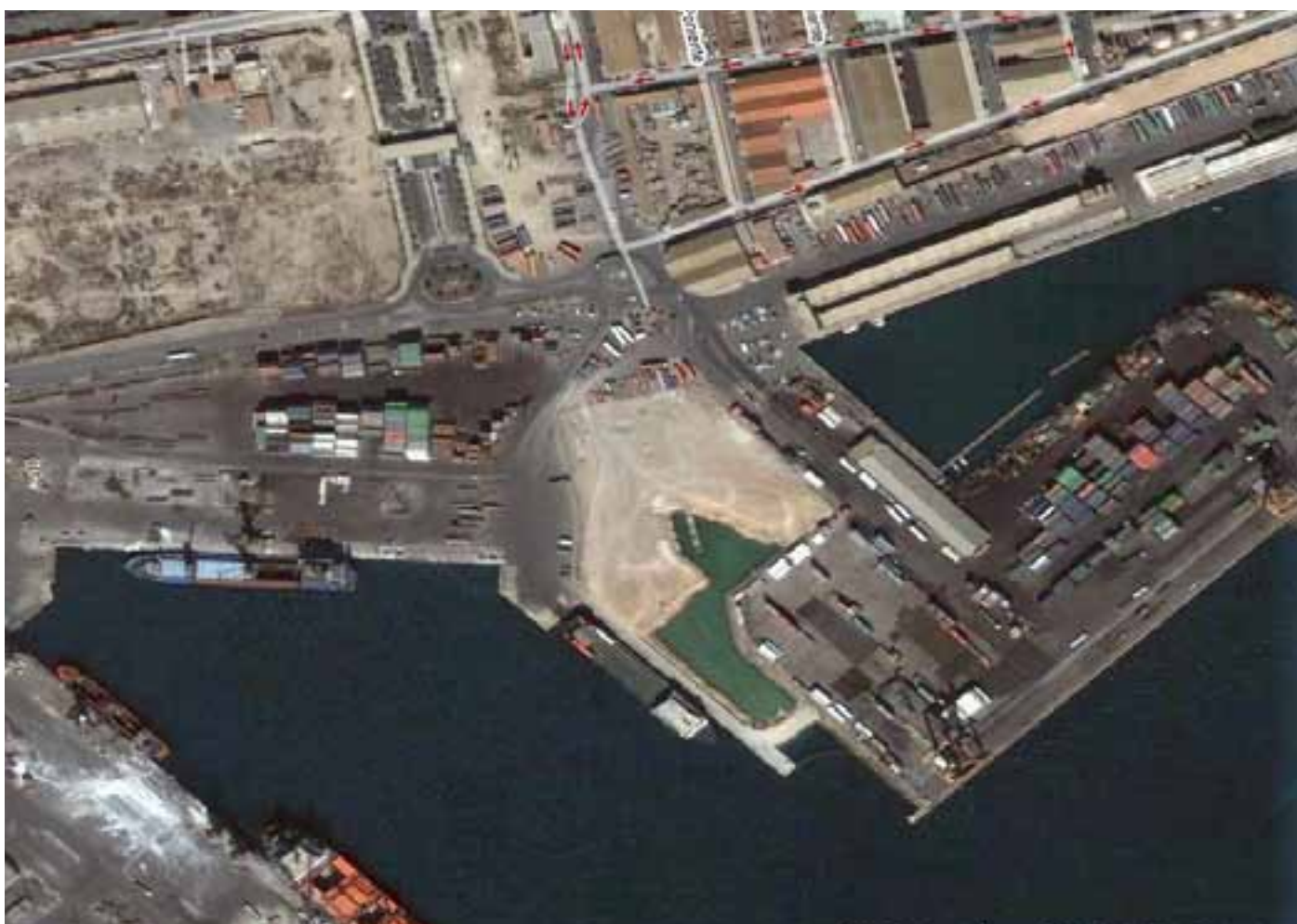
Foto aérea de la obra.
