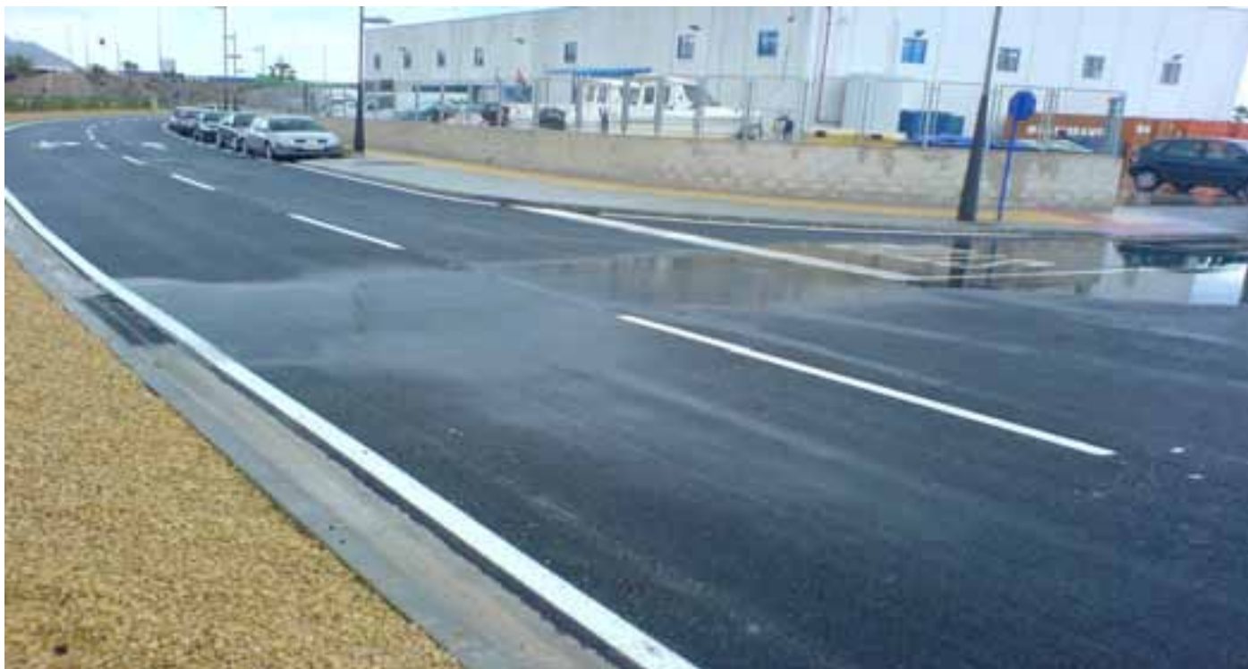
Nuevo asfaltado de los viales
