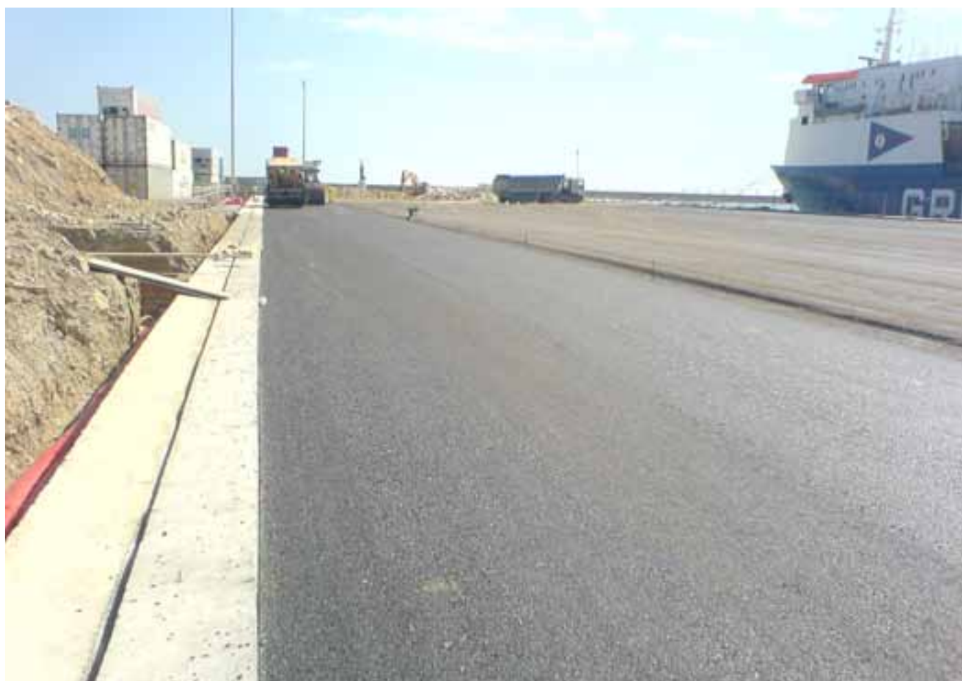
Foto durante la realizacion de la obra.
