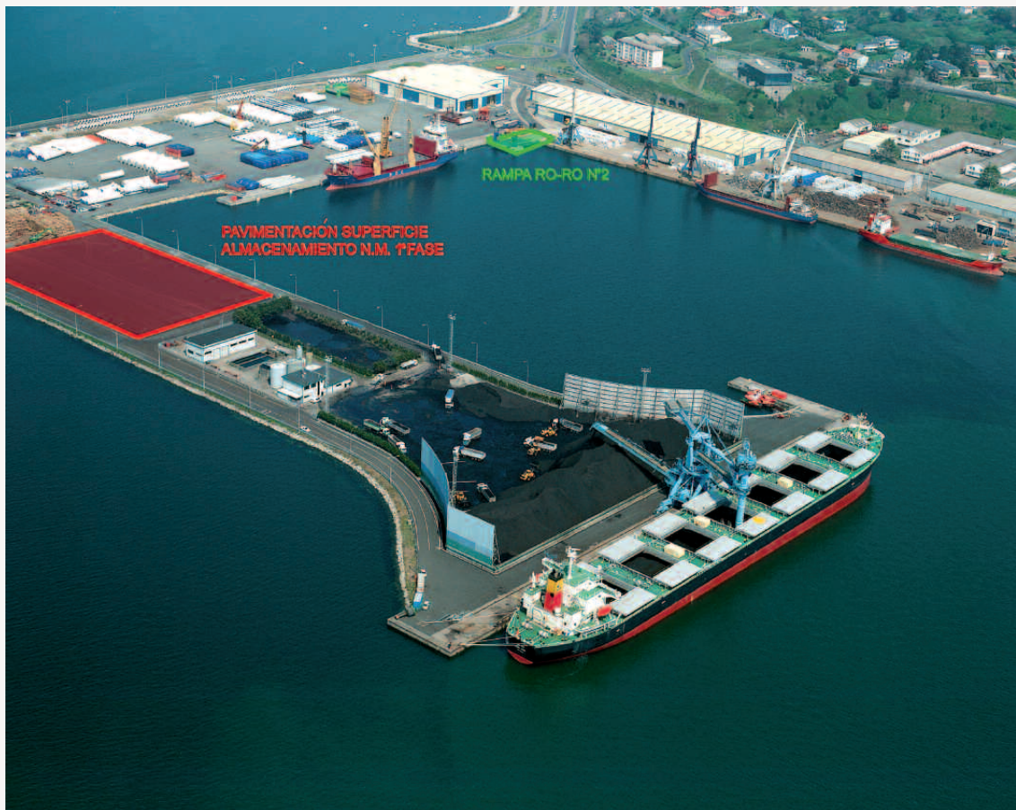
Vista aérea del Nuevo Muelle y Muelle Cerramiento Norte.
