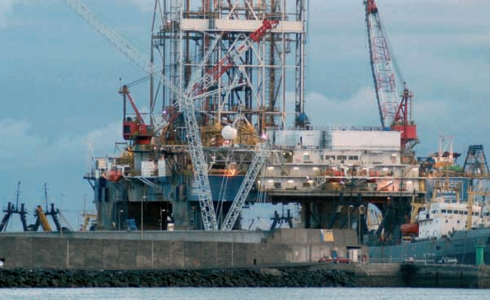
PLATAFORMA PETROLÍFERA EN LABORES DE MANTENIMIENTO
