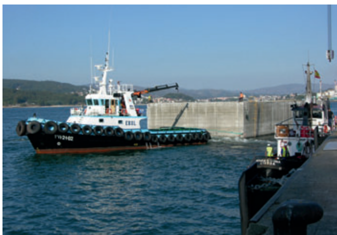
Botadura del primer cajón para el nuevo muelle.
