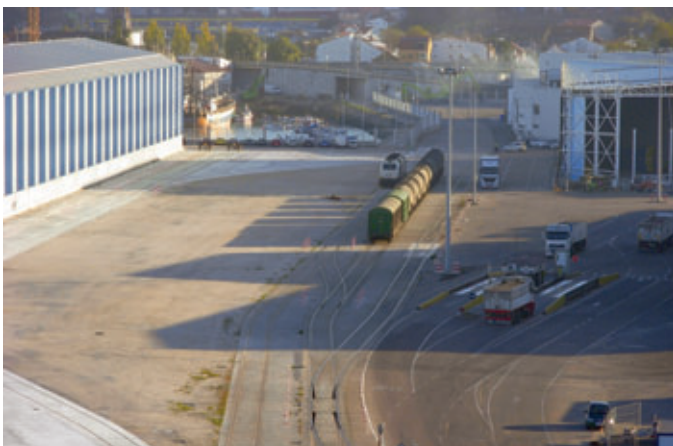
El Puerto de Marín cuenta ya con más de 5.000 metros de vías.
