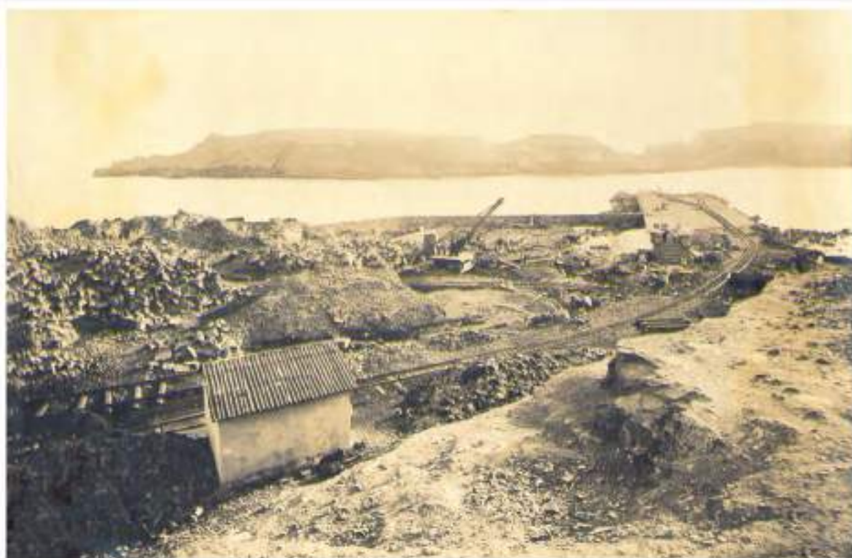
Inicio construcción puerto de Choforinas 1906.
