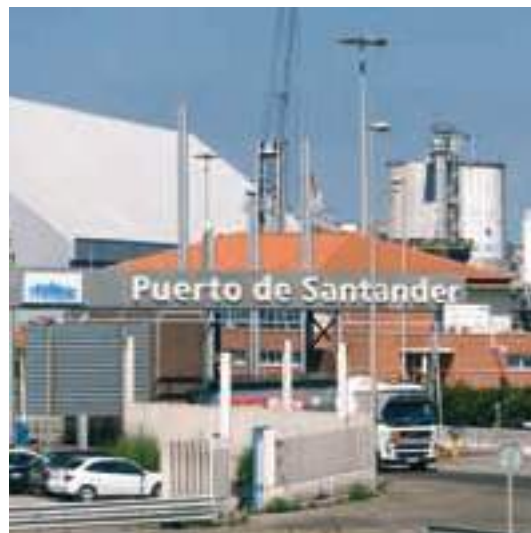
Control de accesos de Raos Oeste.
