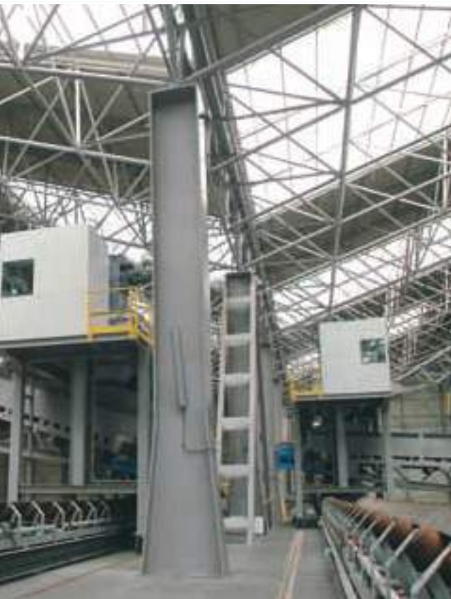
Interior de la "Terminal de Graneles Sólidos Minerales".
