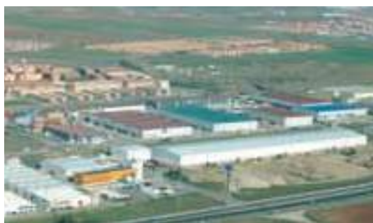
Vista general del Puerto Seco de Azuqueca.
