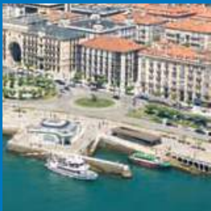
■ Muelle Calderón Superficie total: 4,887 m 2 Longitud de muelle: 270 m Calado: 3 m Usos: Servicios auxiliares
