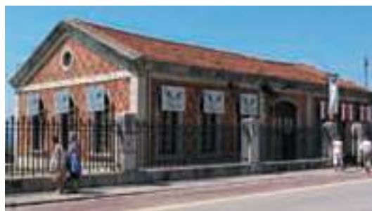
Caseta de Bombas de Dique de Gamazo, durante la Exposición "Gegitsu Dock". Foto: Pedro Cantero, 2007.
