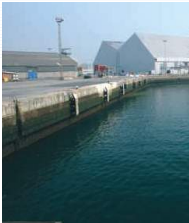
Muelles de Raos 7 y Raos 1 con la "Terminal de Graneles Sólidos Minerales" al fondo.
