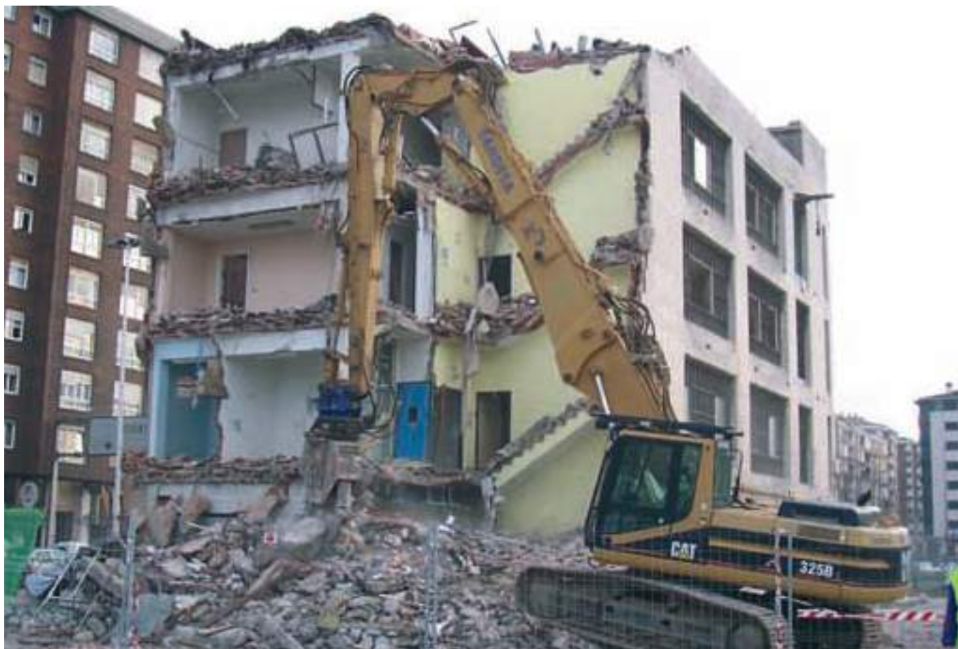
Derribo del Edificio de la Cruz Roja en el Área de Varadero.
