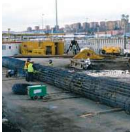
Trabajos de construcción del nuevo acceso al Muelle de Maliaño.
