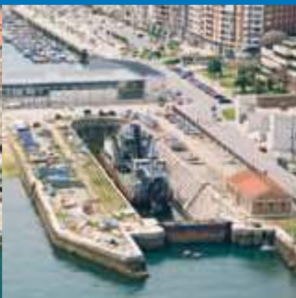
■ Muelle de Gamazo Superficie total: 2,035 m 2 Longitud de muelle: 105 m Calado: 4 m Usos: Servicios auxiliares
