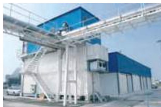
Nueva cámara de hielo y cámaras frigoríficas de la Lonja Pesquera de Santander.
