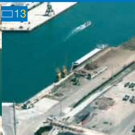
■ Muelle de Nueva Montaña Quijano Superficie total: 10,474 m 2 Longitud de muelle: 218 m Calado: 5 m Usos: Graneles sólidos Instalaciones: 2 grúas automóviles externas
