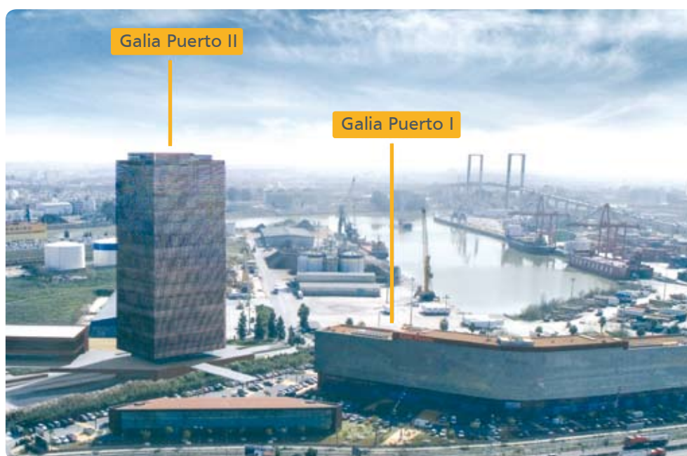
Galia Puerto II en ejecución
