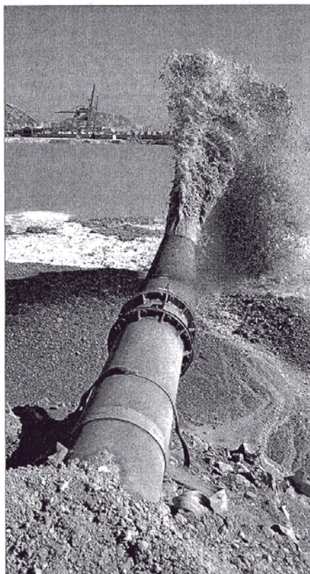
Una tubería vierte tierra en el mar para ampliar el puerto. / ALEX DOMÍNGUEZ
