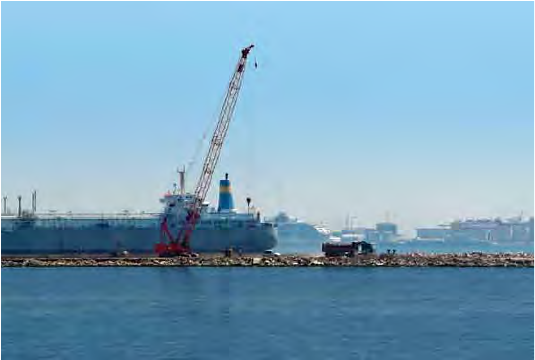
Izquierda: Construcción de cajones para el dique de Isla Verde Exterior. Derecha: Obras en Isla Verde Exterior. Left: caisson building for the Isla Verde Exterior BreakwaterRight: Works on Isla Verde Exterior
