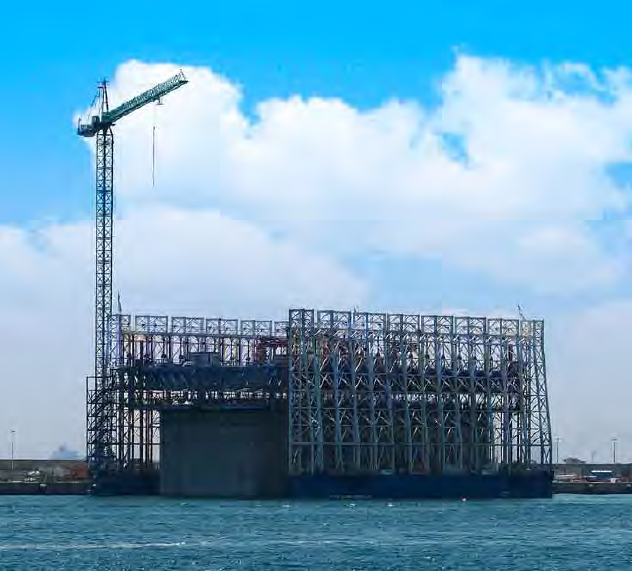
Buque cajonero donde se construyen los elementos de gravedad del dique de abrigo de Isla Verde Exterior. Caisson Ship, where Isla Verde Exterior Breakwater gravity components are built.
