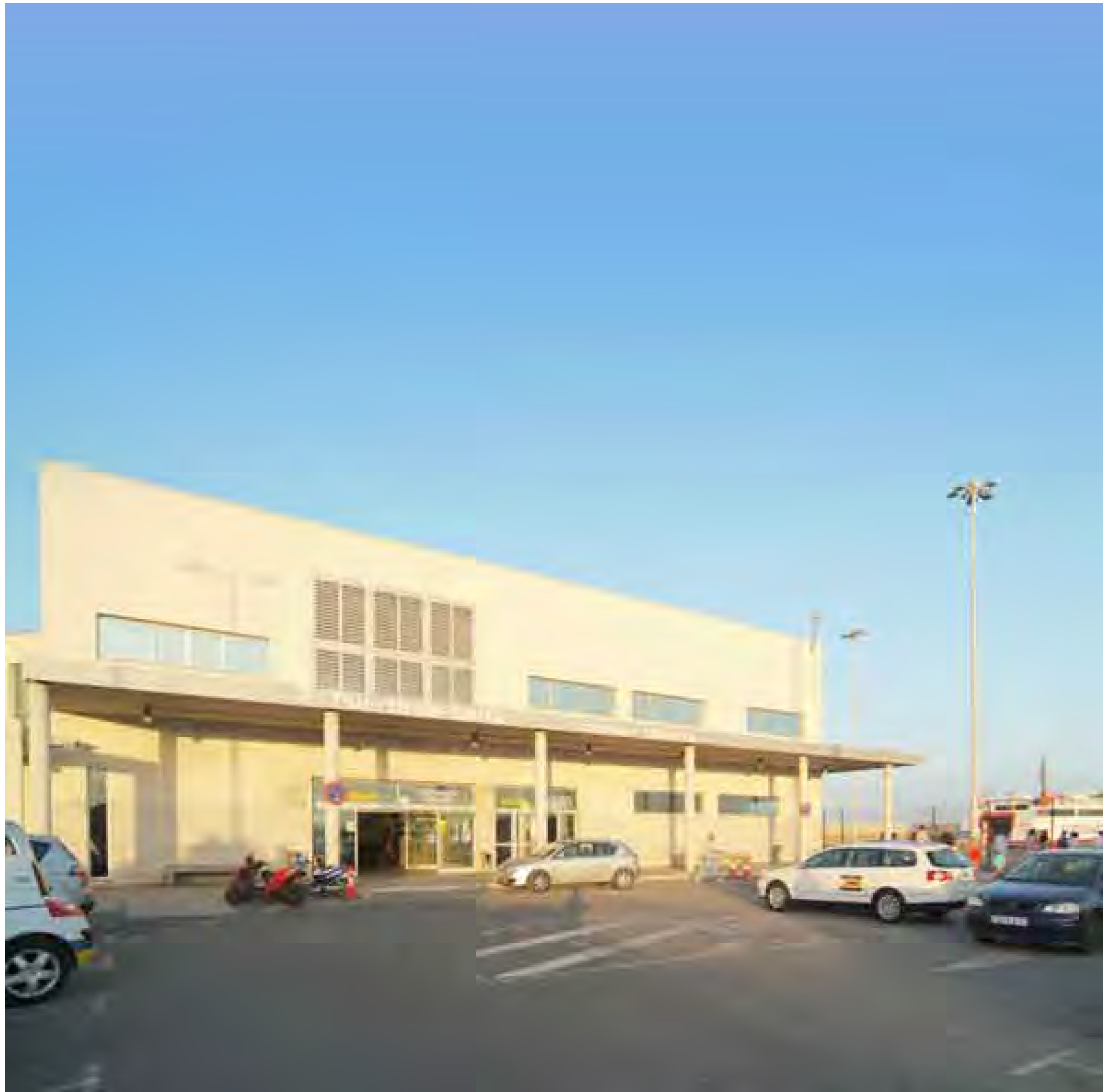
Estación marítima de Tarifa. Tarifa Passenger Terminal.
