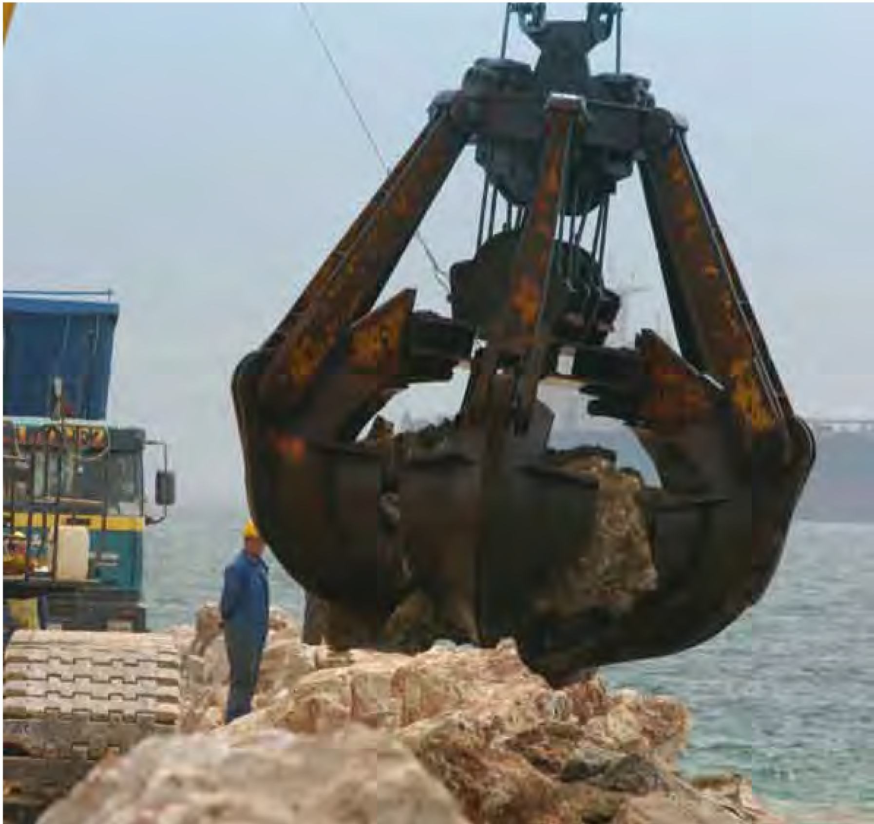
Colocación de escollera en talud de banqueta de alineación en el Muelle Este. Placing a sloping rockfill berm alignment on East Quay.
