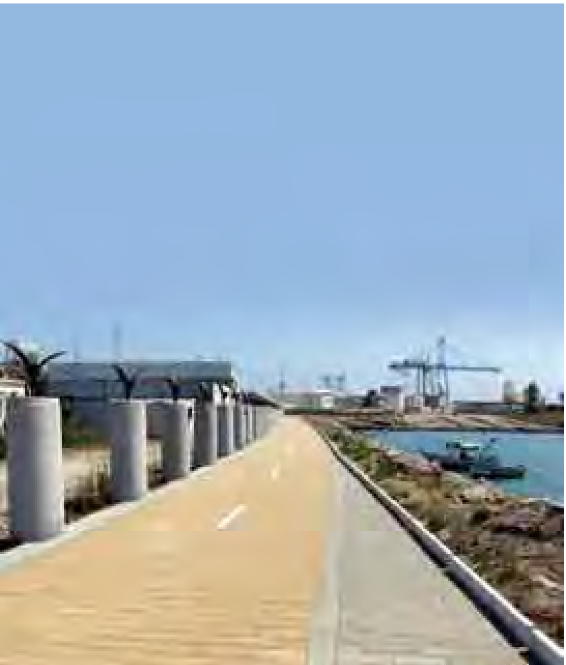
Carril bici desde el Acceso Sur hasta el Fuerte de Isla Verde. Cycle path from the Southern Access to Isla Verde Fort.
