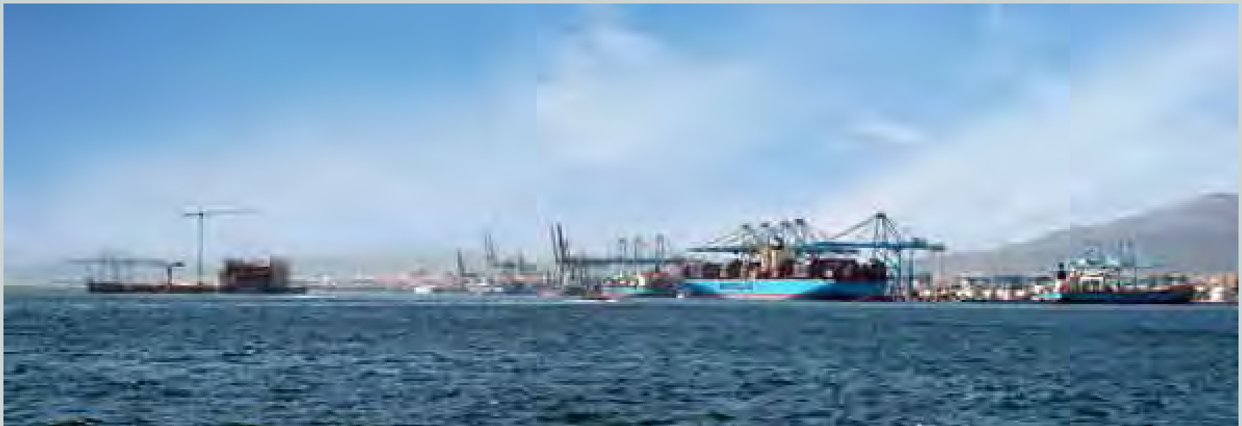
Vista general del puerto de Algeciras con las obras de Isla Verde Exterior a la izquierda de la imagen. General overview of the Port of Algeciras, with works on Isla Verde Exterior to the left
