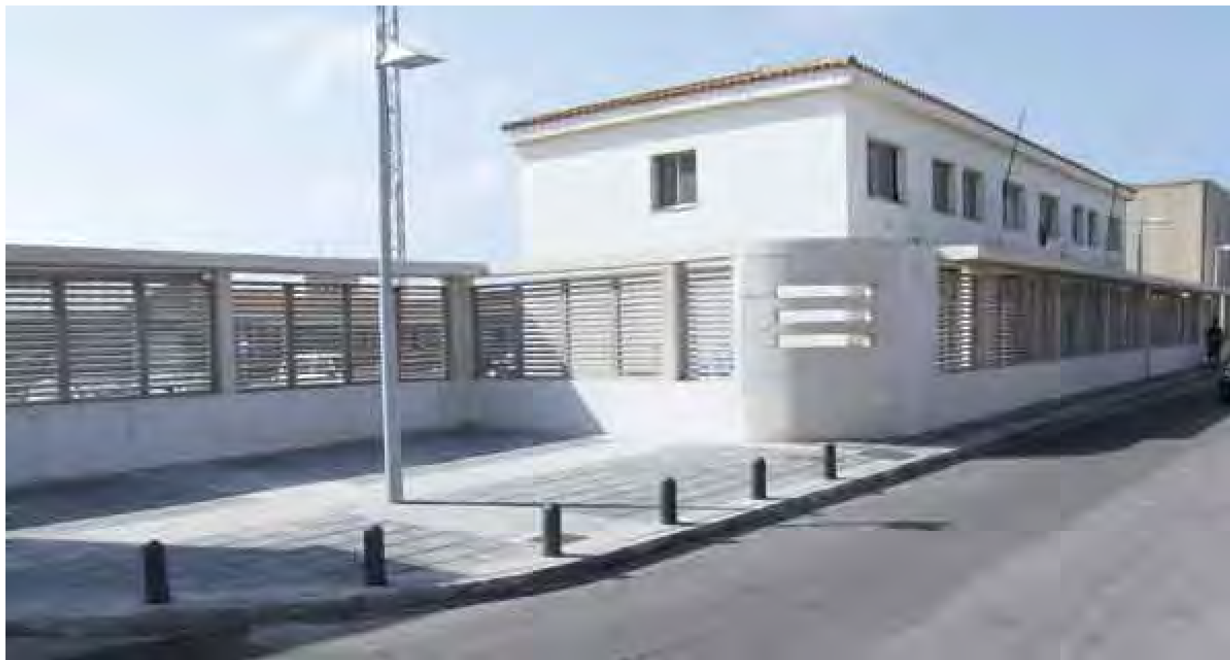
2ª Fase del cerramiento del Puerto de Tarifa. 2nd Phase work to Tarifa Port enclosure.
