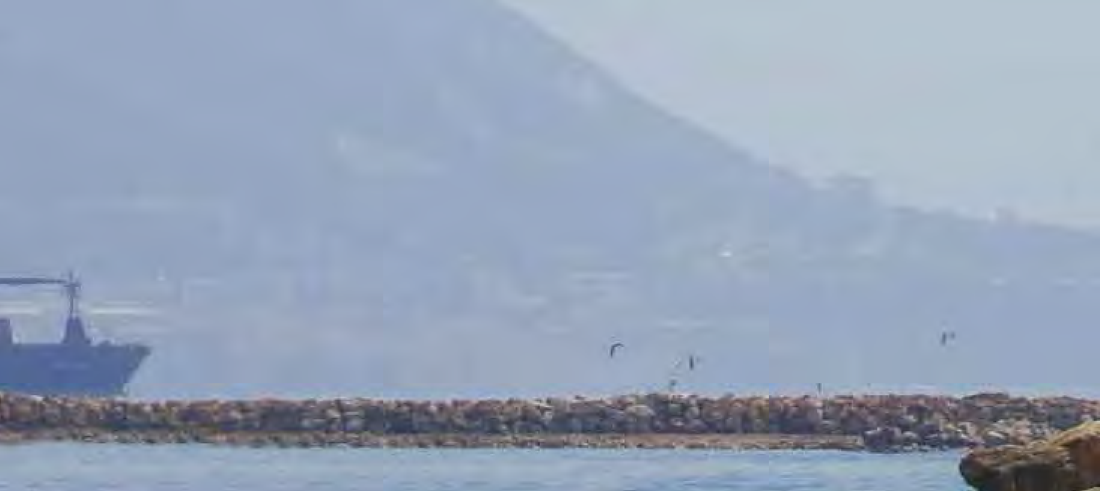
Obras en la Fase 3 de Isla Verde Exterior. Phase III Works in Outer Isla Verde.
