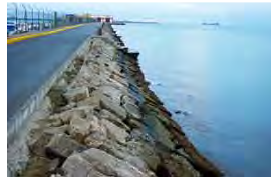
Ensanche del contradique del puerto, en La Línea. Breakwater reinforcement work at La Línea Port.
