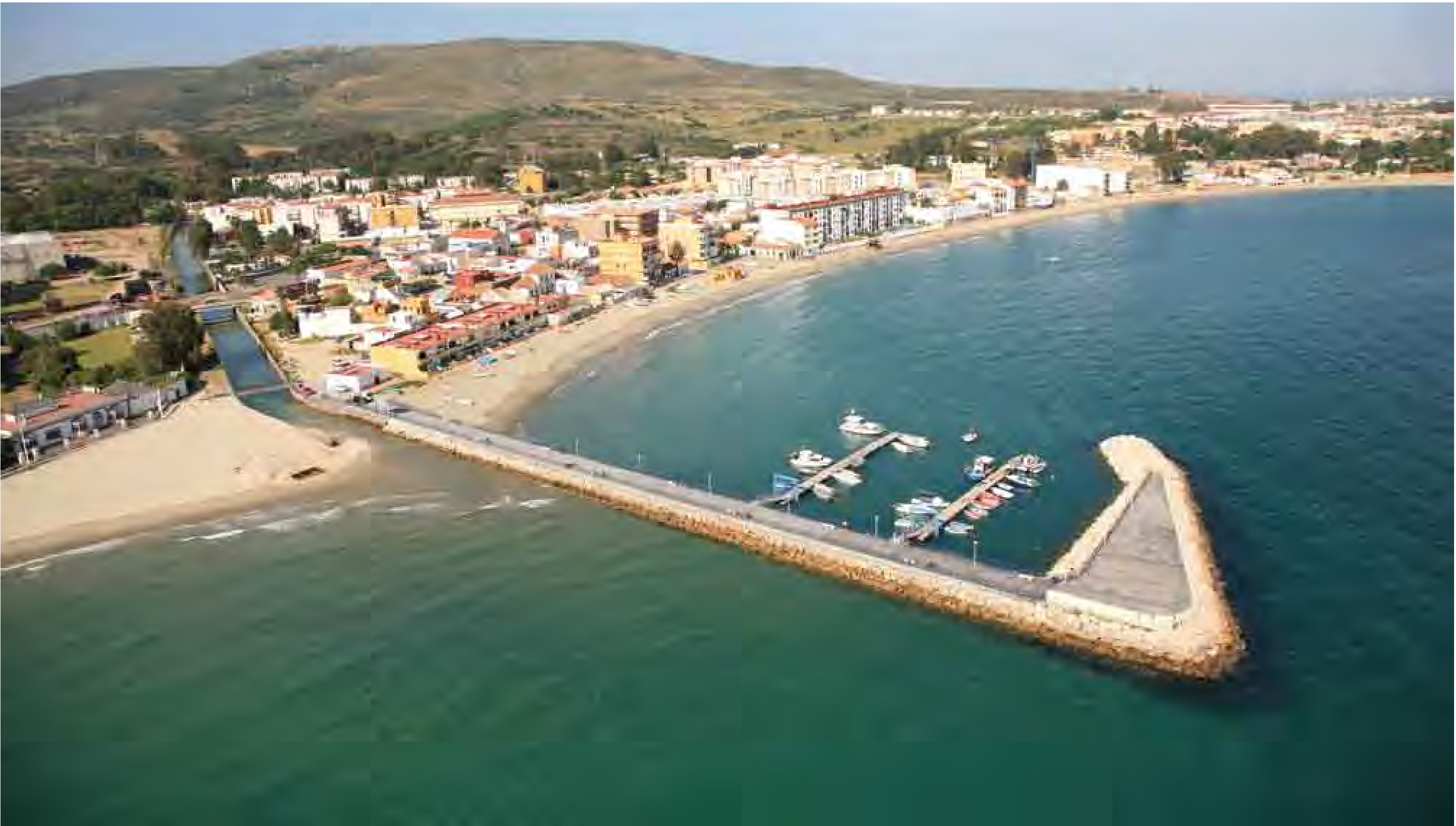
Prolongación y pavimentación de la coronación del espigón de la desembocadura del arroyo de Los Gallegos en Puente Mayorga, San Roque. Extension and surfacing work to the Los Gallegos Rivermouth Pier crown in Puente Mayorga (San Roque).
