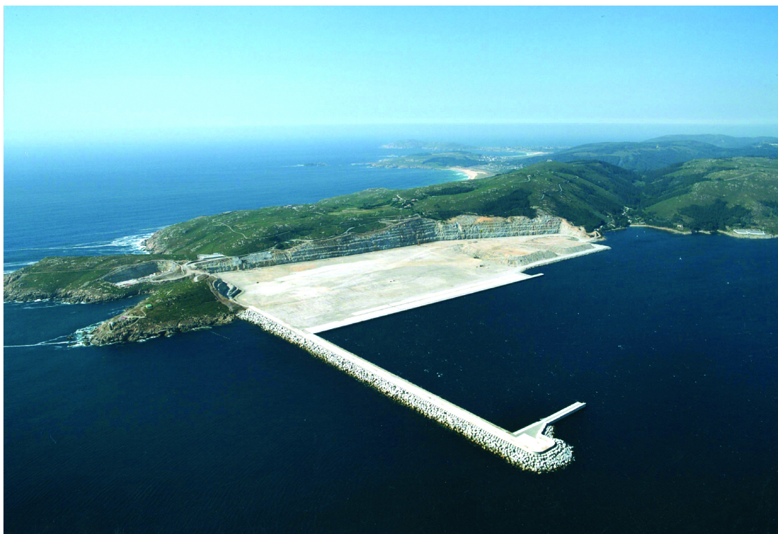
Fotografía de estado de las obras a su finalización (Junio 2005)
