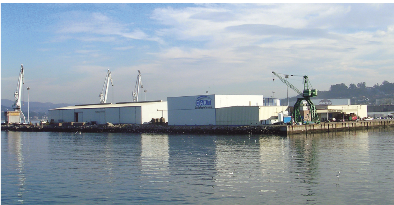
Vista de las instalaciones de DART.
