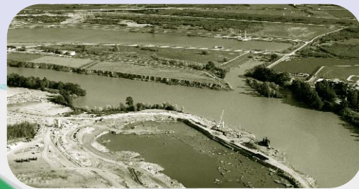
PROGRAMA ESCLUSA Nuevo acceso marítimo, nuevo puerto.
