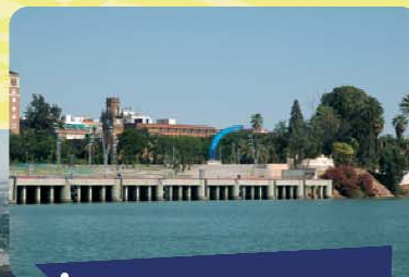
Recuperación de la denominada grúa gran 1 de 1875 (situada en la Plaza de acceso a la sede de la Autoridad Portuaria de Sevilla)
