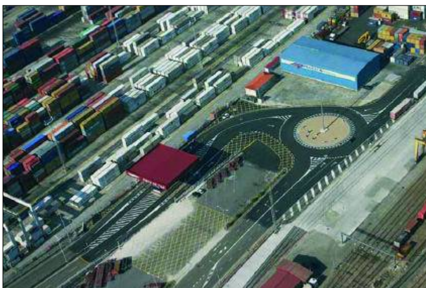
Nuevo acceso al Muelle de Guixar
