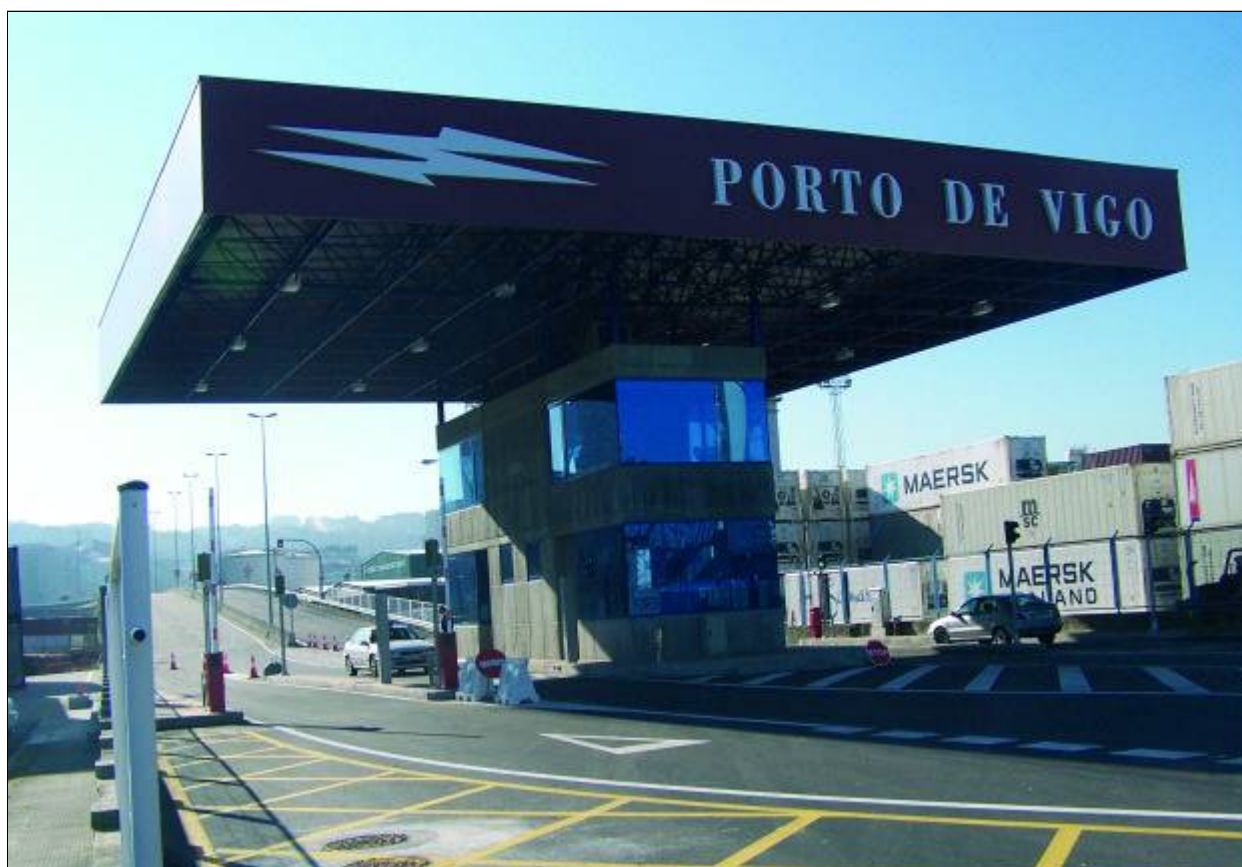
Obra del Nuevo Acceso al Muelle de Guixar
