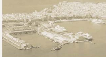
EN OBRAS. Zona en la que se trabaja para nuevos aparcamientos de camiones y remolques ro-ro.
