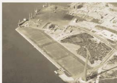
Los trabajos en la dársena de La Cabezuela-Puerto Real comenzaron en julio de 2002.
