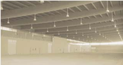
EN OBRAS. Las nuevas zonas pesqueras en el muelle de El Puerto de Santa María se encuentran en obras y están terminadas este año.
