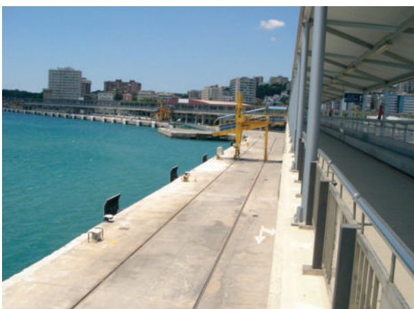
Pasarela Muelles de Poniente en el Puerto de Palma.
