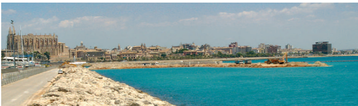
Inicio de la obra en la explanada de los Muelles Comerciales del Puerto de Palma.
