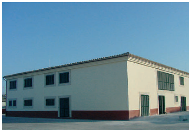
Edificio para utillaje y almacén en Alcudia.
