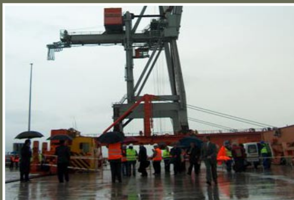
Grúas portacontenedores Terminal Polivalente de Castellón
