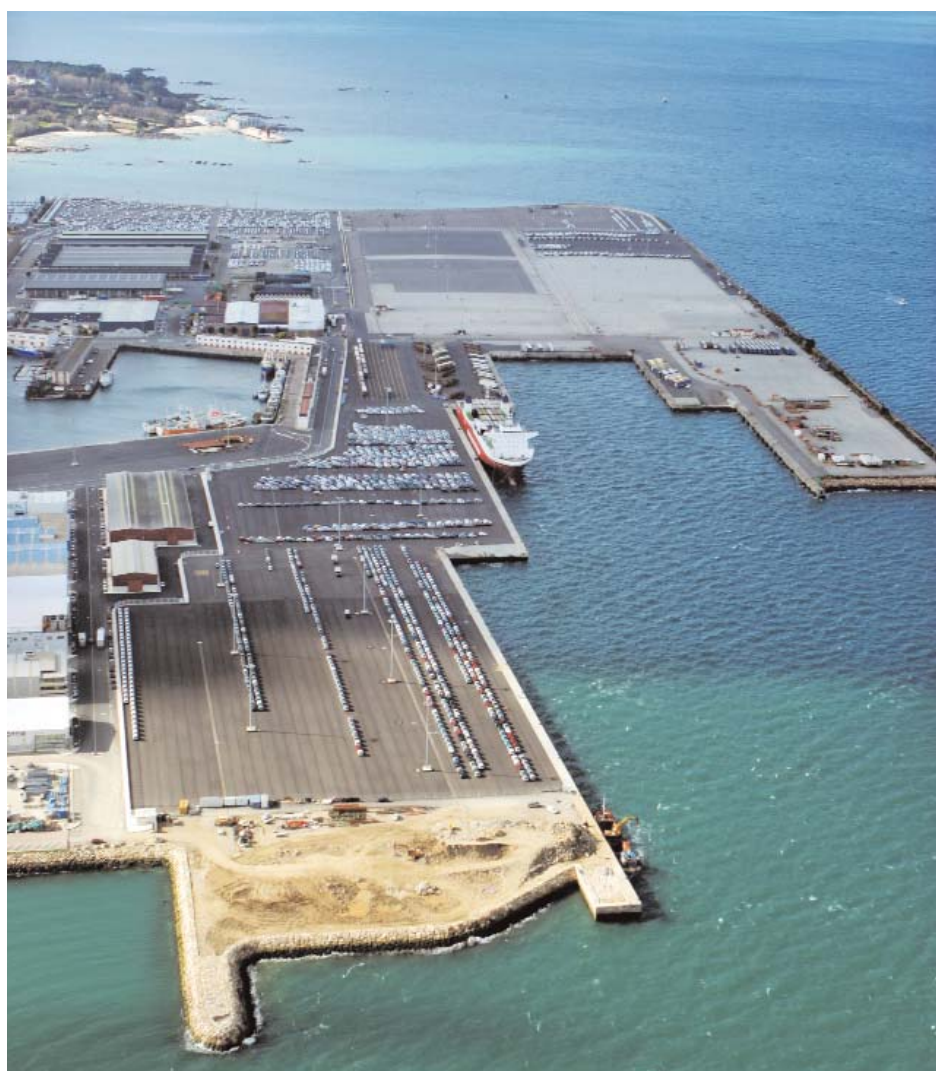
Ampliación de la Terminal de Transbordadores de Bouzas.
