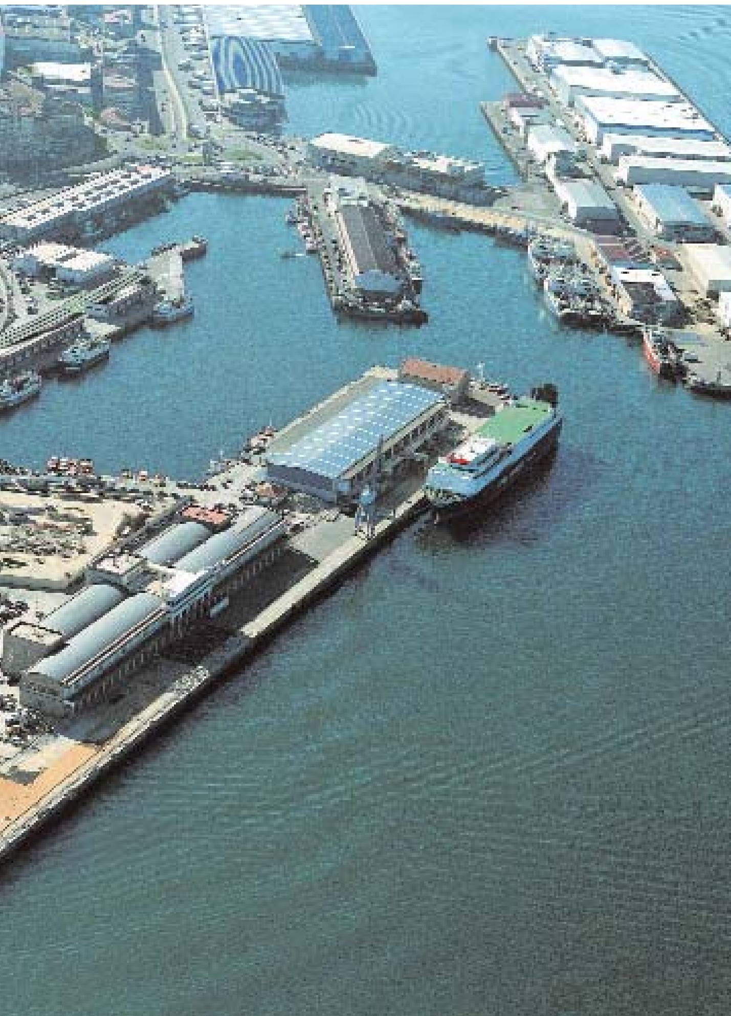
Obras de acondicionamiento del Muelle de Trasatlánticos y dragado de la dársena para el atraque de las embarcaciones participantes en la regata "Volvo Ocean Race" (Fotografía de Paisajes Españoles)
