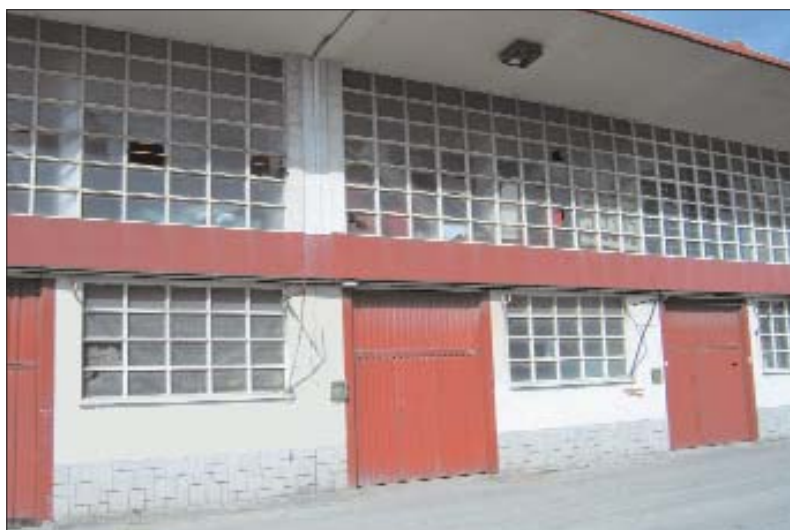
Local de Armadores a remodelar. Primer plano empresa Portillo-Lumada
