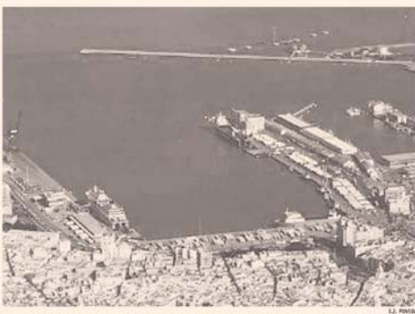
El crecimiento de la actividad portuaria en el Puerto de Cádiz hace necesario la ampliación de los muelles.
