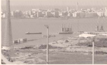
Vista de las obras de ampliación del muelle Sur de la Cabezuela-Puerto Real / Foto: VM
