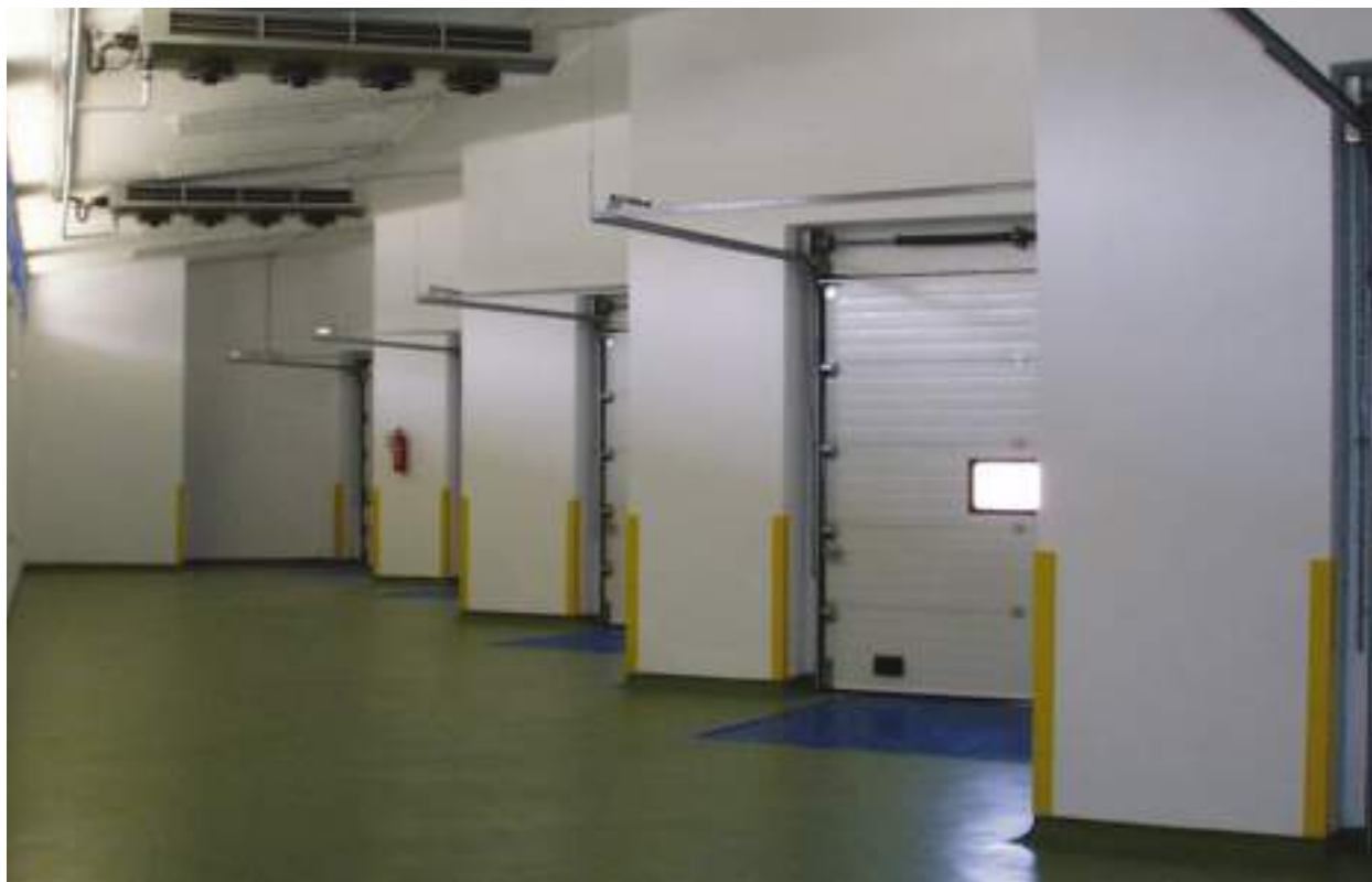
Puerto de Inspección Fronteriza (PIF). Vista interior
