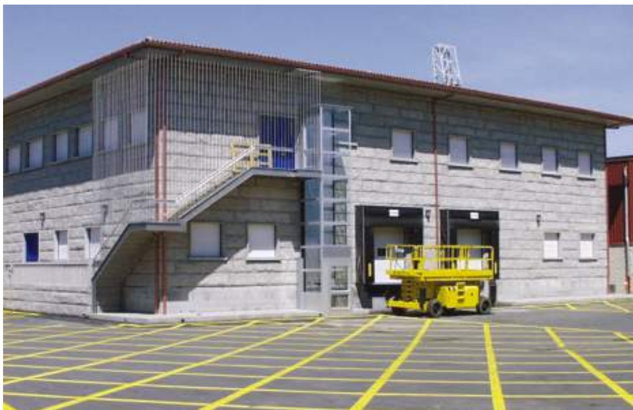
Puerto de Inspección Fronteriza (PIF). Vista exterior
