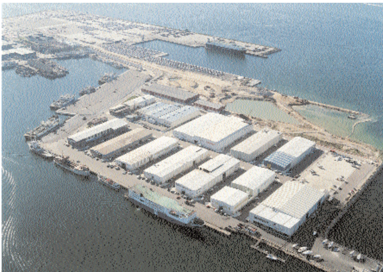
Vista aérea de la Terminal de Transbordadores y Concesiones en el Muelle de Bouzas. (Fotografía de Paisajes Españoles)
