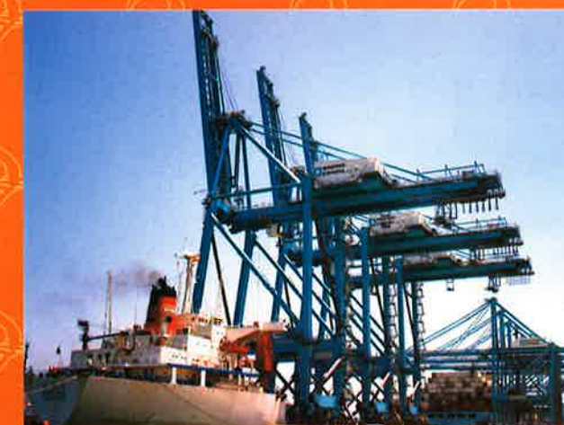
Junio 2002 - Llegada de tres nuevas grúas super post Panamax a la terminal de Maersk España. June 2002 Arrival of three new Super Post Panamax cranes at Maersk España's Terminal
