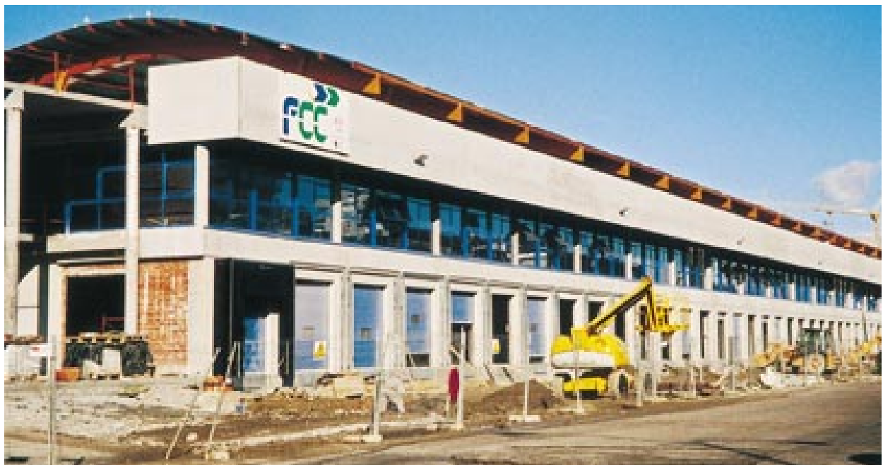
Construcción de la Lonja de Grandes Peces y Pesca de Bajura. (9/12/2002)
