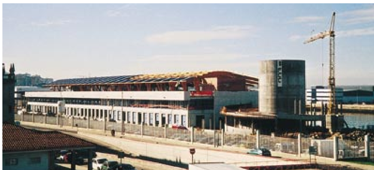
Construcción de la Lonja de Grandes Peces y Pesca de Bajura. (9/12/2002)
