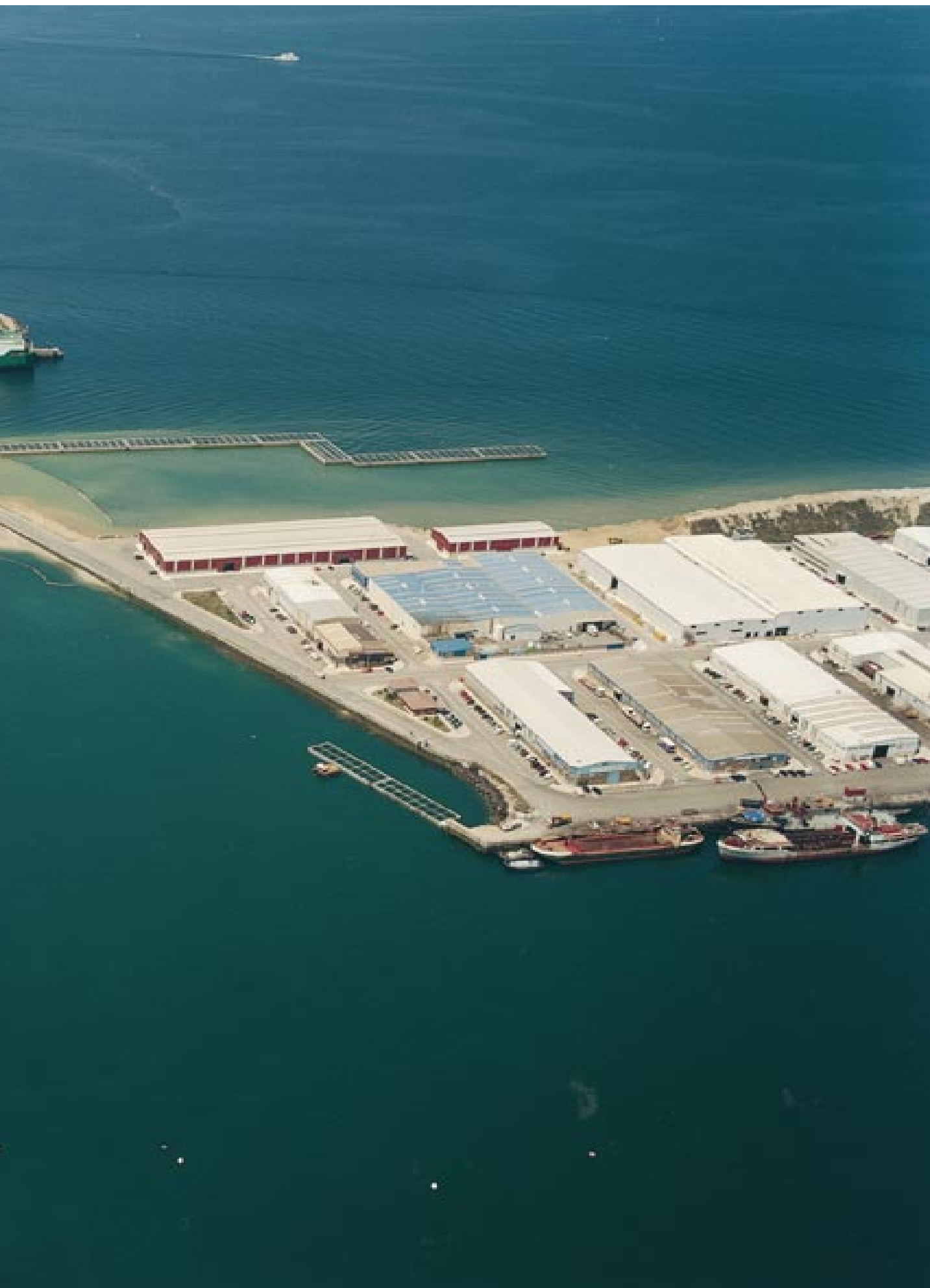
Obra de ampliación de la Terminal de Transbordadores de Bouzas e inicio de la obra de ampliación del Muelle de Reparaciones de Buques Pesqueros. (17/07/2002)
