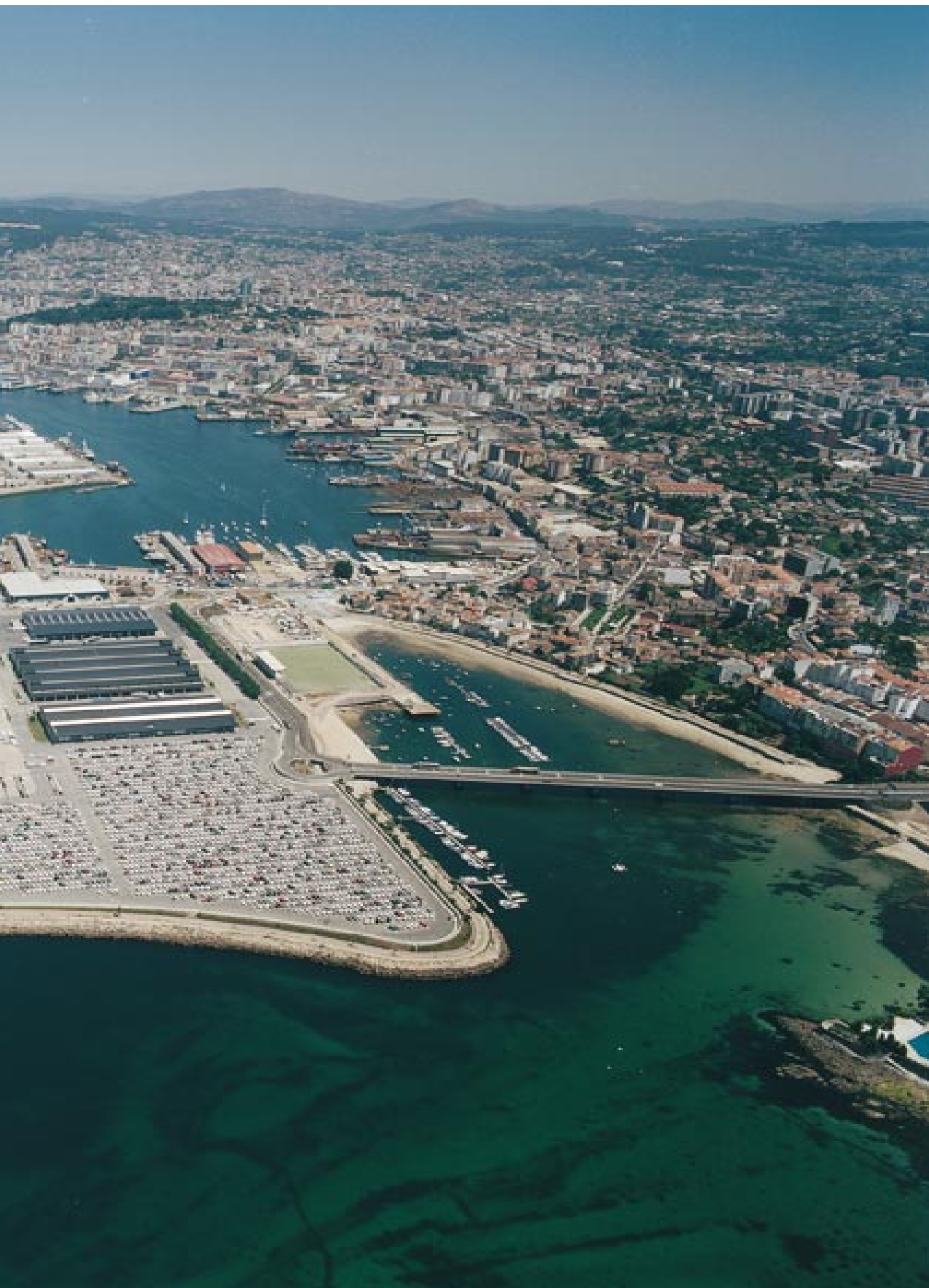
Terminal de trasbordadores de Bouzas. Vista aérea. (17/07/2002)
