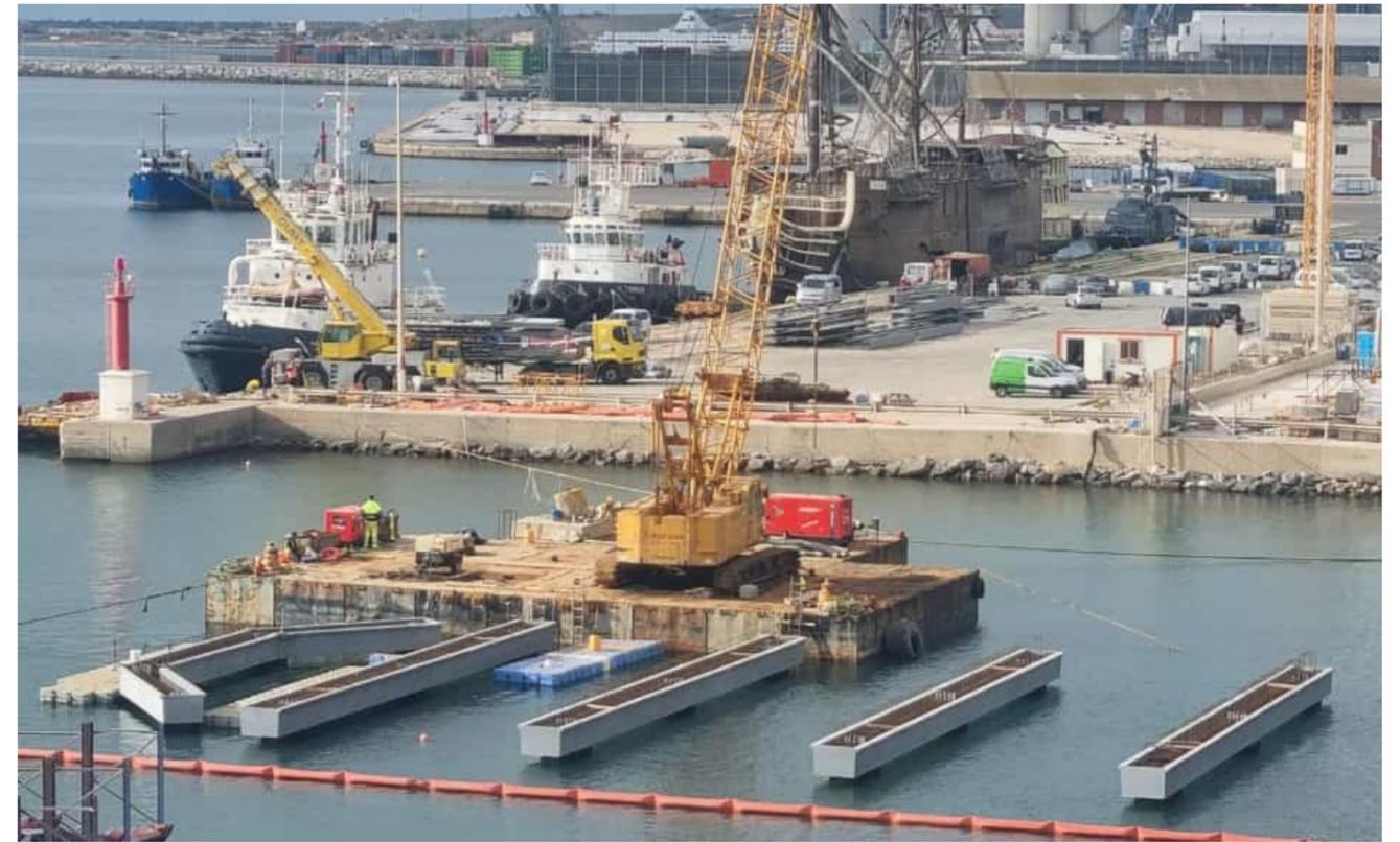
Imagen ejecución obras: Vigas prefabricadas UHPC
