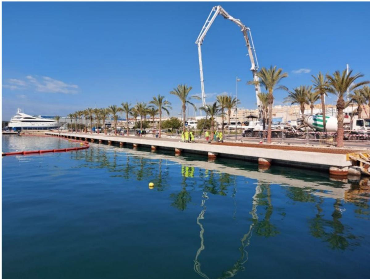
Imagen hormigonado losa Muelle C
