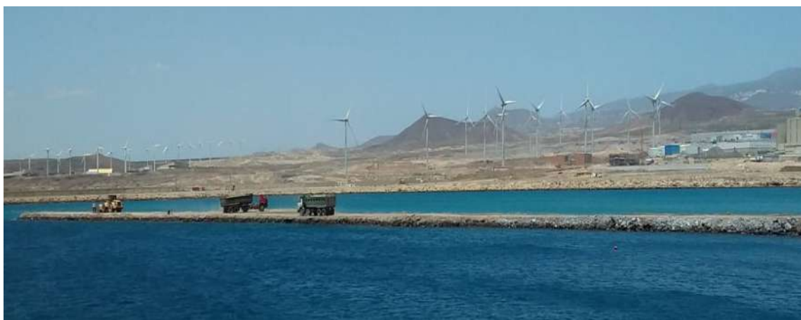
Vista Este-Oeste del dique de cierre
