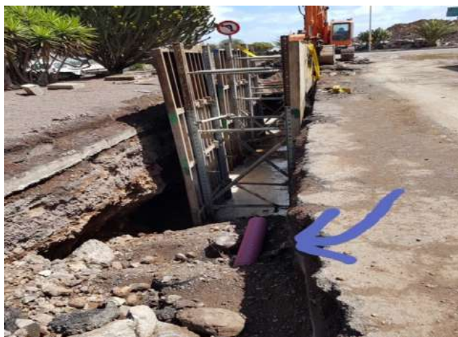
Foto de excavación de zanja para instalación de la red de saneamiento
