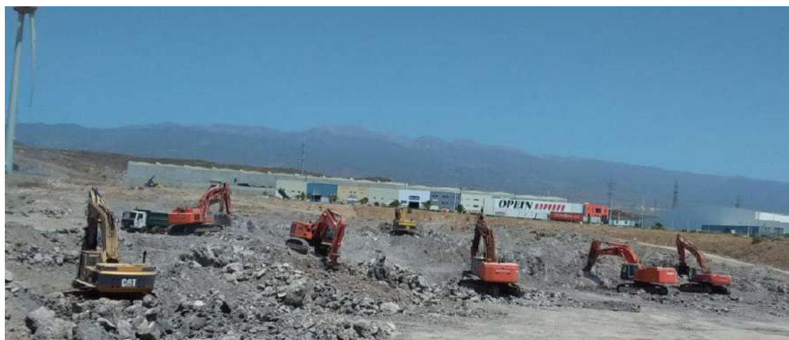
Movimiento de Tierras en el Polígono.
