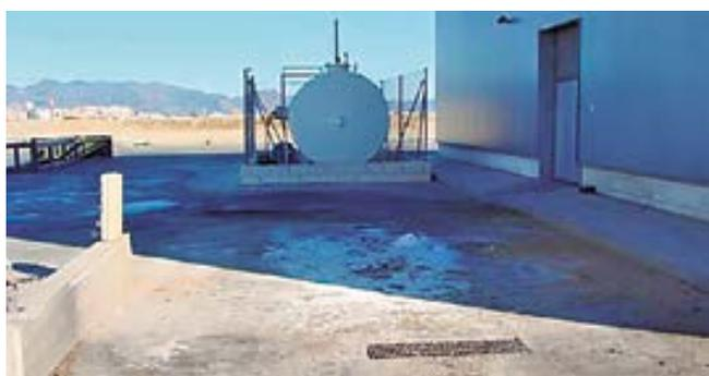
Área de lavado de maquinaria con recogida y tratamiento del agua por decantación y separación de hidrocarburos
