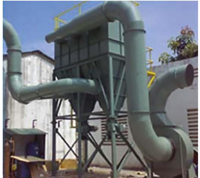
Detalle de la unidad de filtrado y extracción de un filtro centralizado
