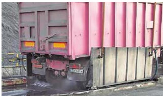
Los sistemas lavaruedas a la salida de parques de graneles limitan la dispersión de partículas por rodadura.
