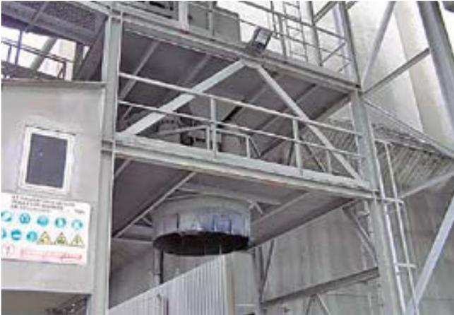
Control de emisiones en carga de camión mediante mangas con aspiración.
