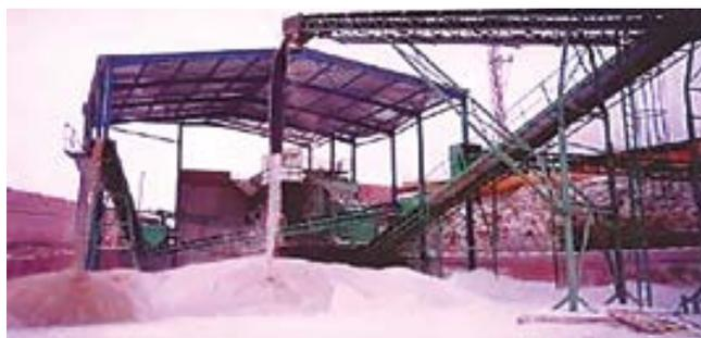
Implantación de un sistema de pulverización de agua con aditivos tensoactivos en sistema de cintas con apilador. Antes y después.
