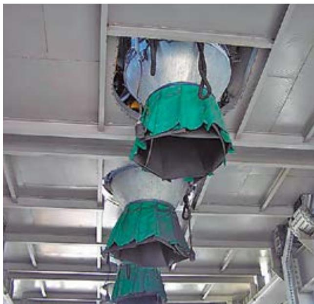
Mangas telescópicas de descarga. Las tres mangas permiten un llenado uniforme de la caja sin necesidad de mover el camión.
