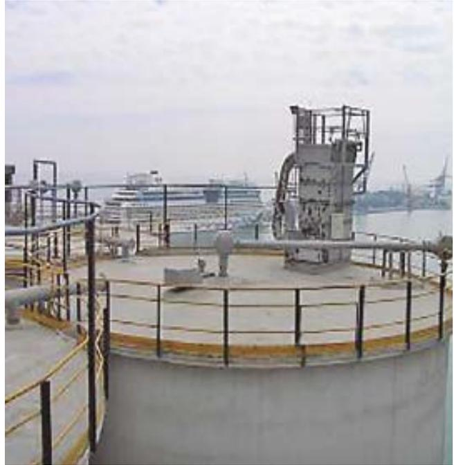
Sistema de aspiración en parte superior del silo para filtrar el aire saliente en el proceso de carga.
