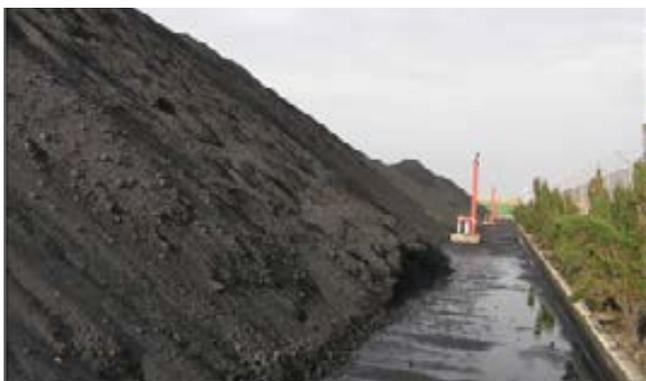
Parque de graneles con sistema de riego y recogida perimetral del agua de riego
