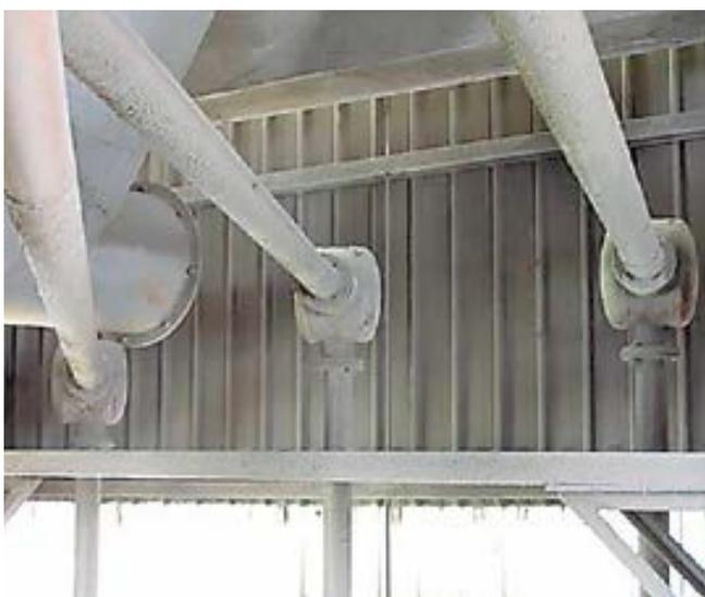
"Codos" en tuberías neumáticas
