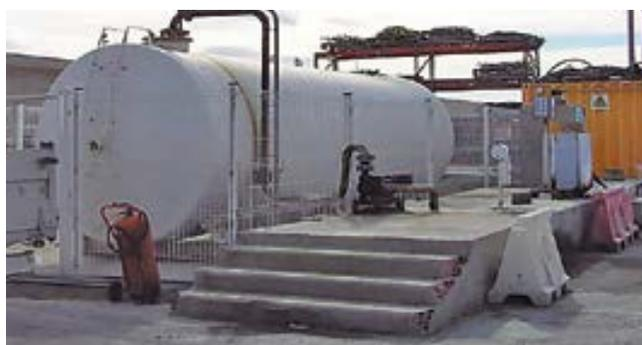
Los depósitos de combustible elevados sobre el suelo permiten detectar posibles fugas. Se instalan además cubetas en conexiones.
