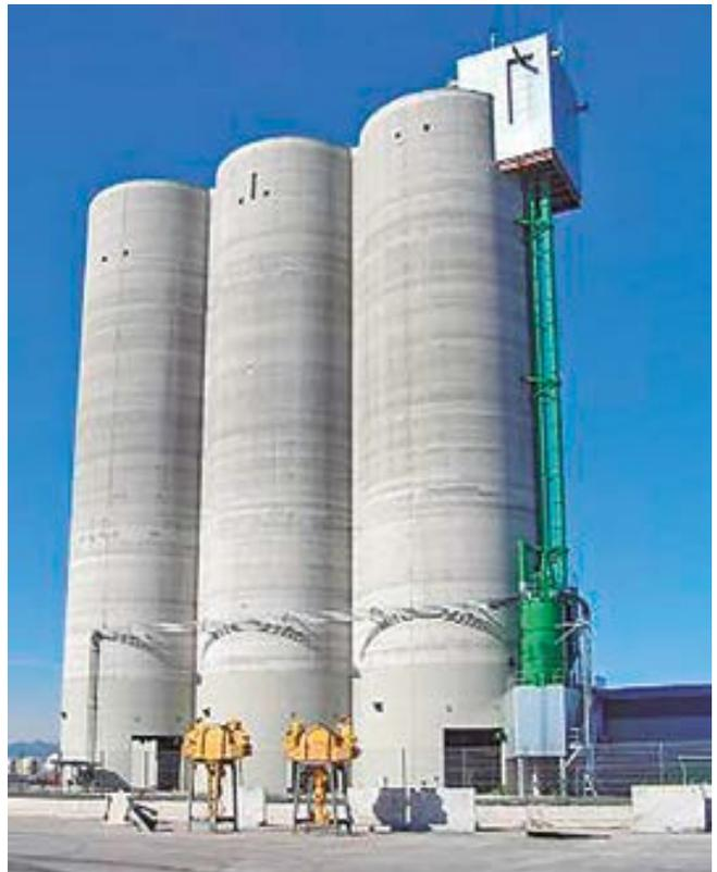
En silos de base cónica, con pendiente pronunciada y materiales fluyentes, la descarga se realiza por gravedad a sistemas de acarreo continuo como cintas, o transportadores de cadenas. Cuando la base es plana o cuando el nivel de fluencia no es alto, la descarga de los silos puede requerir el uso de dispositivos auxiliares que permitan generar un flujo continuo de mercancía, como por ejemplo, barredores circulares, tornillos sin fin, vibradores o sistemas de inyección de aire.
