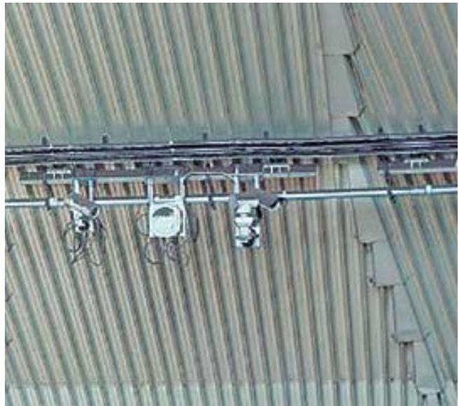
Cámaras termográficas informan de posibles autocombustiones.
