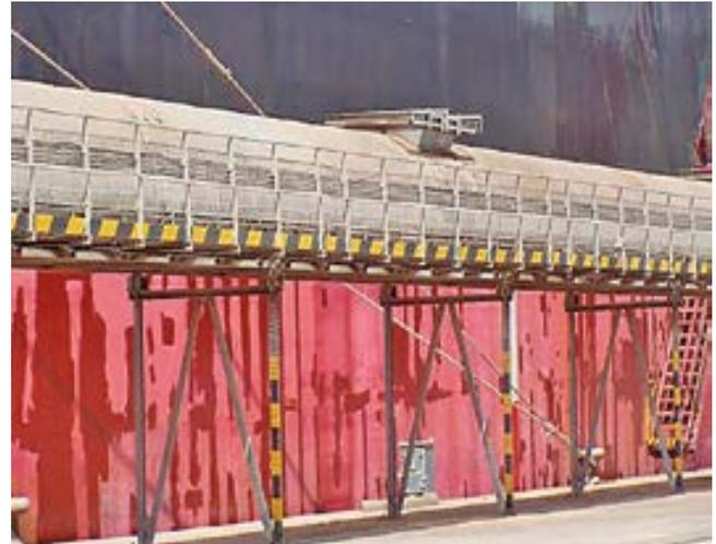
Los sistemas de cinta paralelos al cantil que trascurren a baja cota (Izquierda) pueden dificultar las tareas de mantenimiento de la cinta y de limpieza del cantil. Sistemas a media altura (Derecha) facilitan el mantenimiento y limpieza, permitiendo un uso flexible del muelle.
