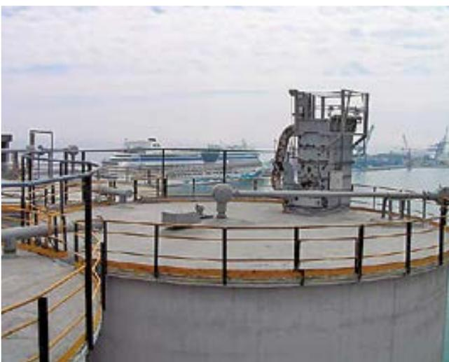
Sistema de aspiración y filtrado del venteo de un conjunto de silos
