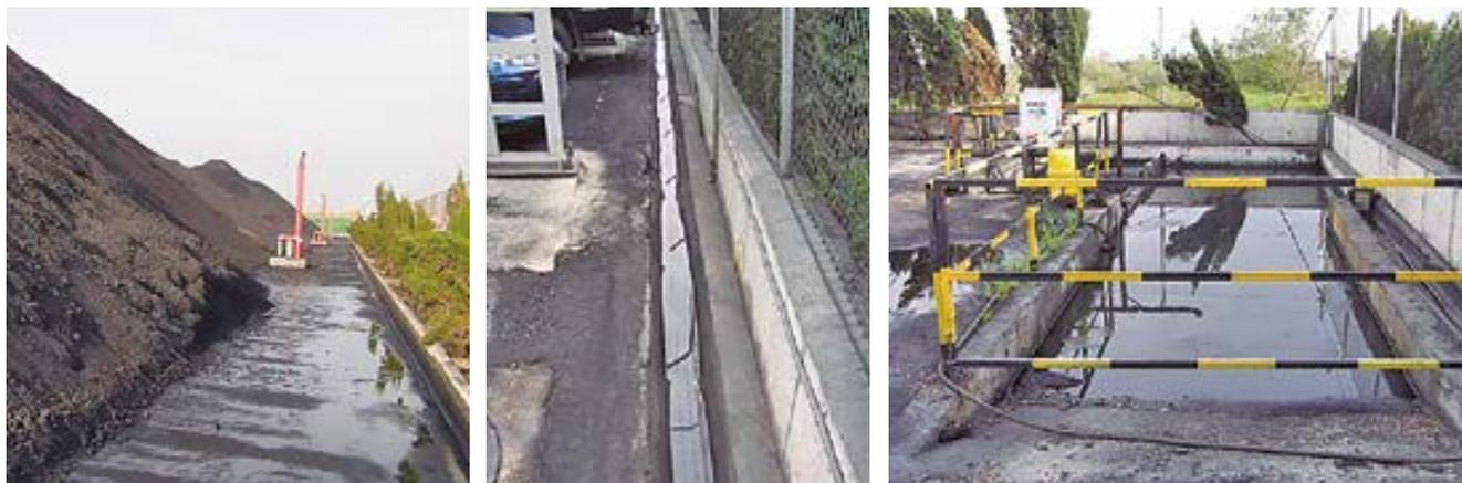
Recogida perimetral de agua de lluvia y riego en parque de graneles para su reutilización como agua de riego. Detalles de la conducción superficial de agua sin partes enterradas y de la balsa de decantación primaria
